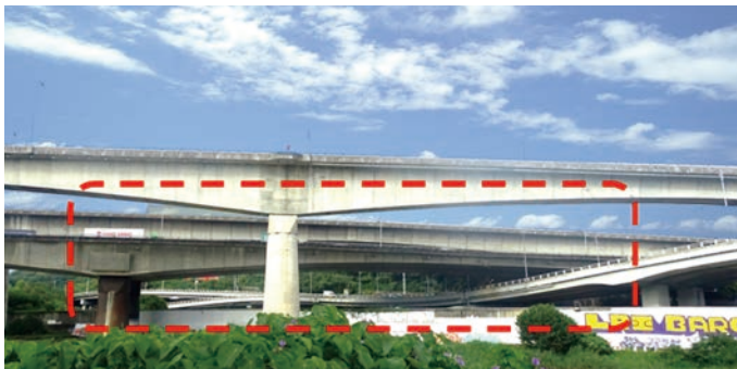
中山高圓山橋中間鉸接端下垂現況
