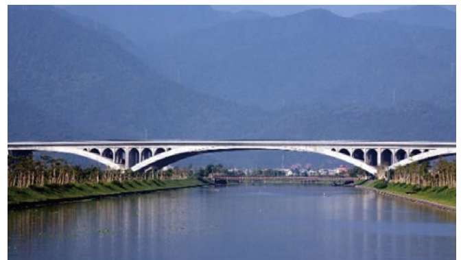
圖 5 冬山河橋（跨徑 94 + 187 + 94 m）
