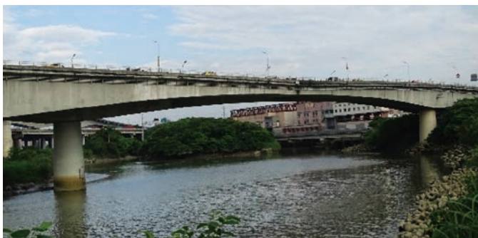
新生高架 — 松江橋中間鉸接端下垂現況
