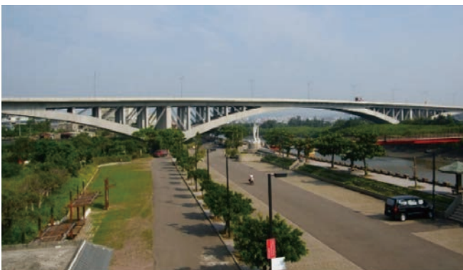
台 61 線新豐溪橋（跨徑 100 + 180 + 100 m）
