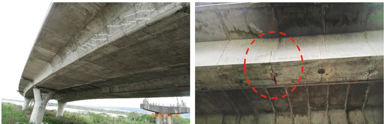
大梁節塊腹板剪力及底板撓曲裂縫
