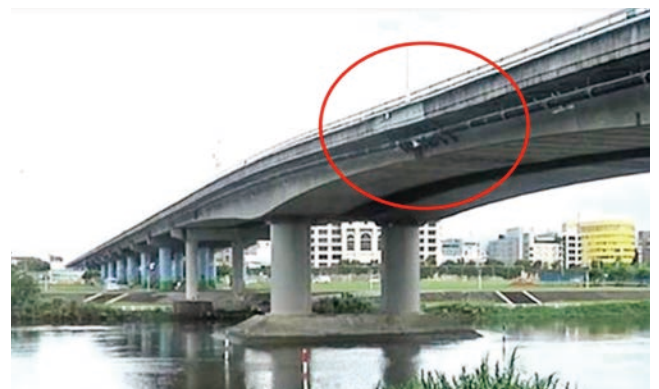
圖 12 台北市民權大橋跨河段主跨中間鉸接處下垂現象
