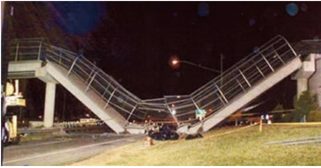
圖 9 美國 Lowe's Bridge 鋼腱腐蝕造成斷裂
