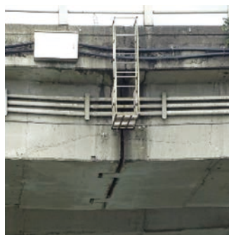
西側鉸接端分離現況
