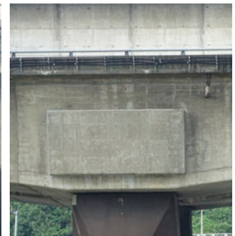
橋墩補強現況
