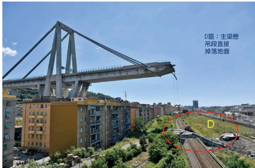
圖 18 橋梁倒塌 D 區照片 [16]
