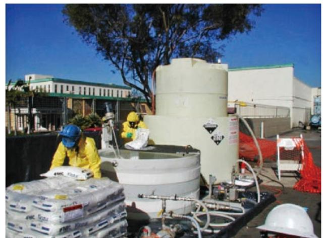
圖 3 以過硫酸鹽現地處理污染地下水之設備單元<sup>[24]</sup>
