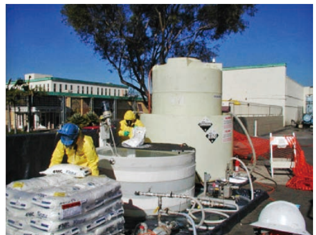
圖 3 以過硫酸鹽現地處理污染地下水之設備單元 [24]
