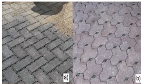
非連續拼接鋪面 Permeable interlocking concrete pavements (PICP)
