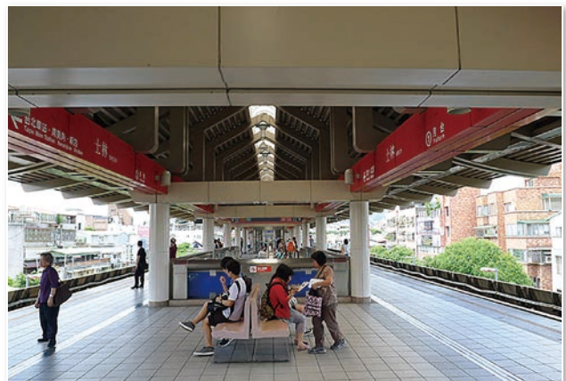
圖 27 台北捷運高架車站月台視野及通風良好（洪如江攝）
