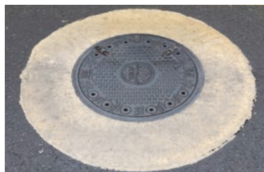
圖 20 圓形切割雨水人孔圖
