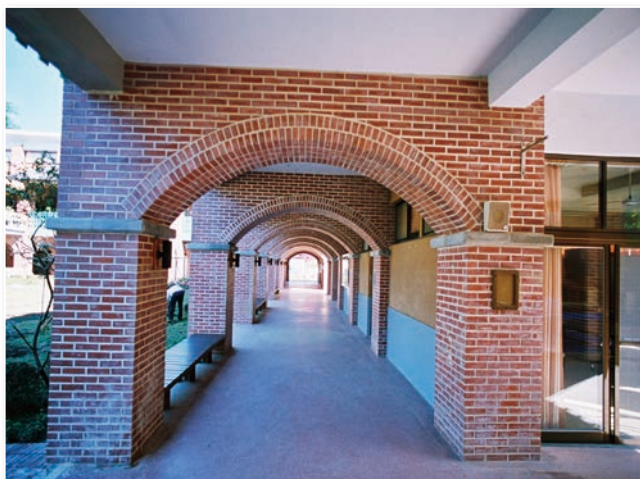
圖 12 民國 88 年 921 地震災後校園重建，教室外拱形走廊，既堅固又方便火災或地震時疏散（洪如江攝）
