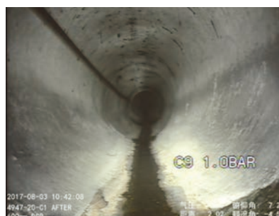
圖 19 小管徑排水系統 TV 檢視車與成果示意圖
