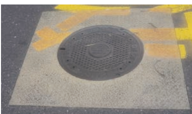
圖 21 防氣掀式雨水人孔圖
