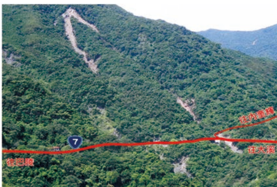
(b) 匹亞崩塌地與鄰接道路
