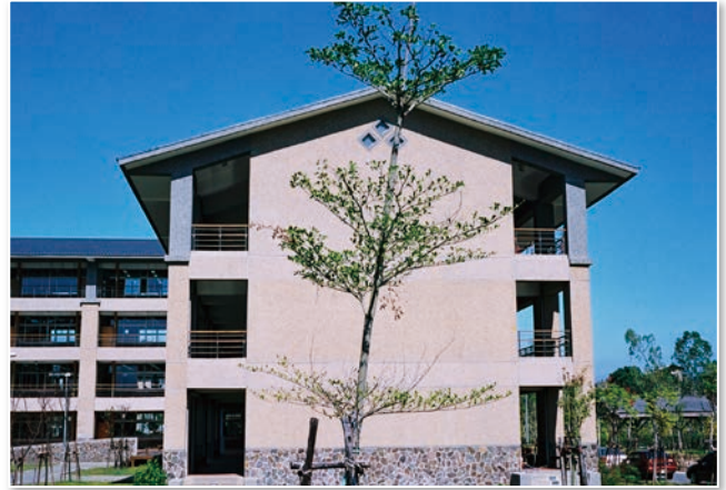
圖 9 民國 88 年 921 地震災後校園重建，校舍多採開放式雙外走廊設計，方便火災或地震時的逃難或救災(洪如江攝)
