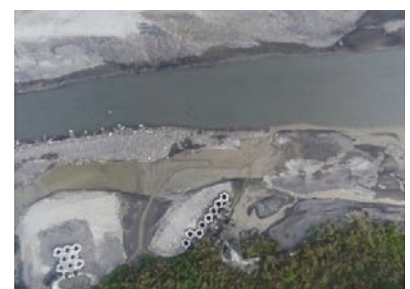
圖 9 濁水溪名竹大橋基腳保護工區
