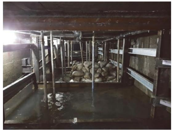
圖 7 箱涵安裝補強鋼框
