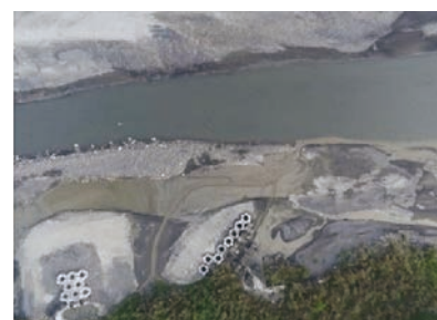
圖 9 濁水溪名竹大橋基腳保護工區
