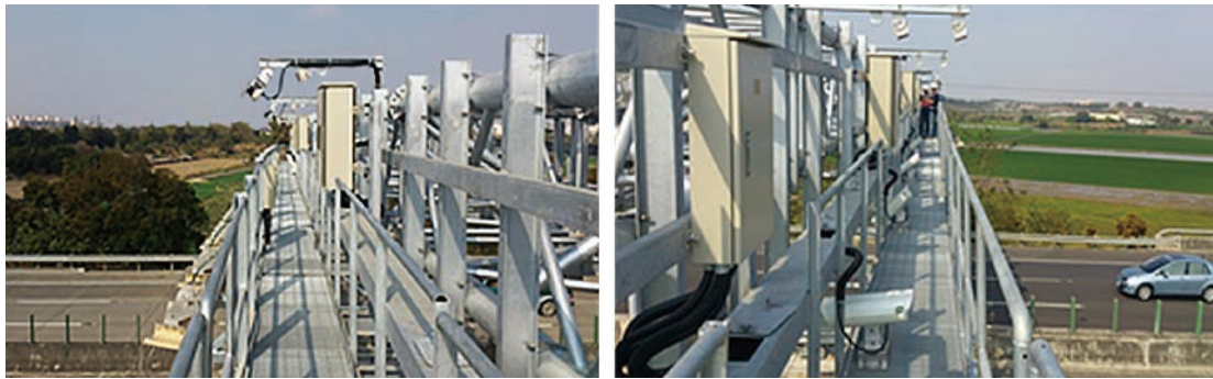
圖 5 ETC 門架前、後走道及走道上設備安裝照片
