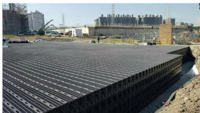
台中南屯文山水資源施工前
