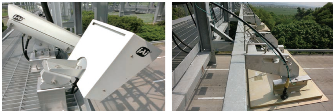
圖 7 車道設備與設備支架安裝照片
