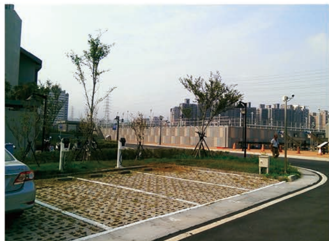
台中南屯文山水資源施工後
