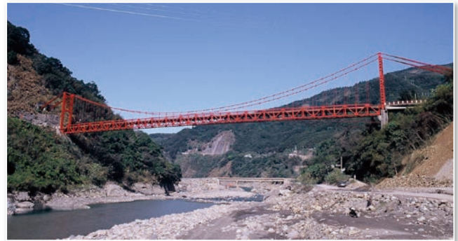
圖 24 北部橫貫公路復興吊橋（洪如江攝）
