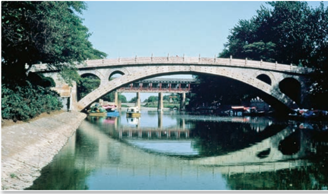
圖 11 中國河北省趙州橋（605AD 完工）全景 橋長 50.82m，橋寬 9m（洪如江攝）
