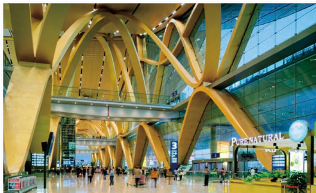
圖 36 昆明國際機場內部波浪形鋼鐵主結構型態的靈感來自雲南民間藝術：彩帶舞（Courtesy of ARUP）
