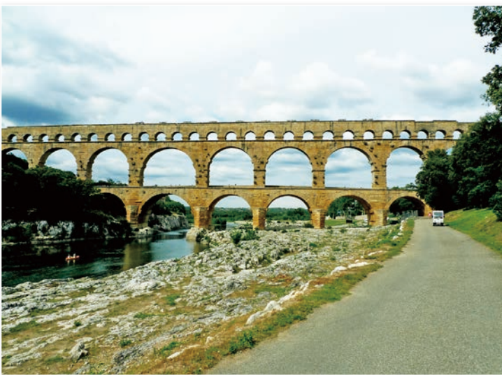
圖 14 羅馬在法國南部所建的嘉德水道橋（Pont du Gard，19BC~）全景（洪以昇攝）
