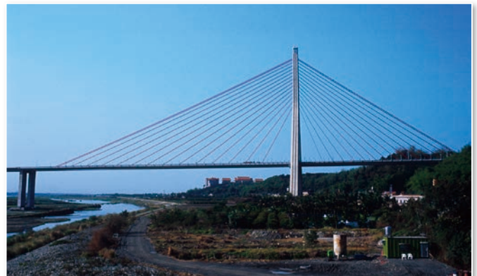
圖 28 南部第二高速公路高屏溪斜張橋（洪如江攝）
