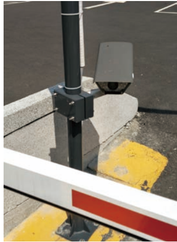
圖 1 智慧停車場的車牌辨識系統 資料來源：台灣國際開發事業有限公司
