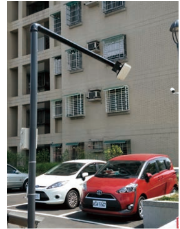
圖 2 智慧停車場的電子標籤讀取器 資料來源：台灣國際開發事業有限公司
