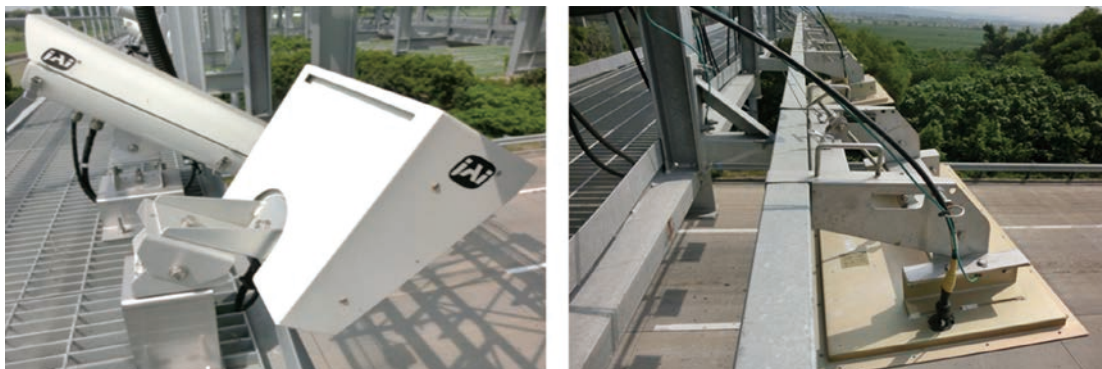
圖 7 車道設備與設備支架安裝照片
