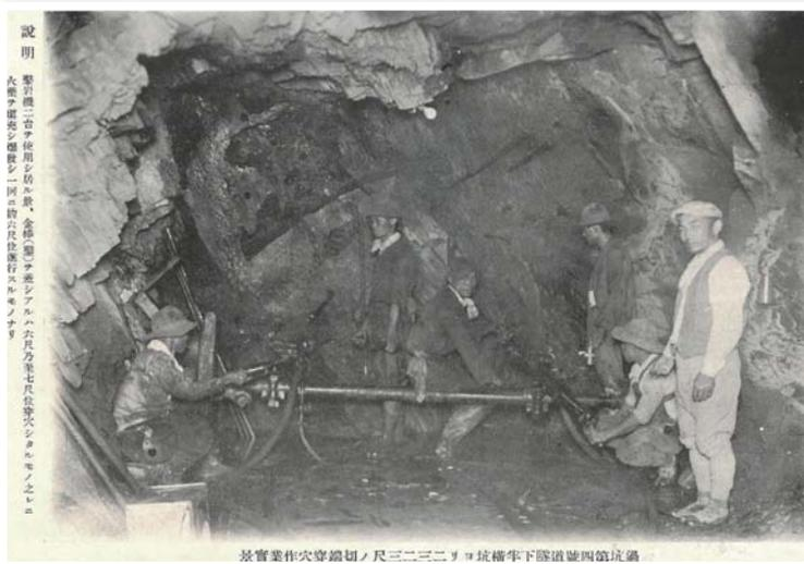
隧道鑽掘由鑿岩機鑽孔、安裝炸藥爆破、出渣等循環進行
