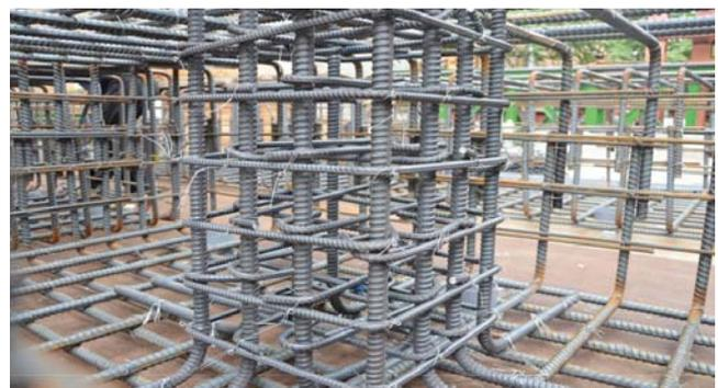
圖 3 NEWRC1,5 基礎鋼筋綁
