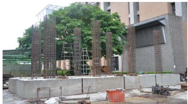
圖 2 BMRC1, NEWRC1,5 柱身鋼筋綁
