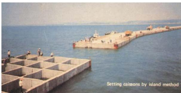
台中港為加速工進，外廓堤防工程以跳島式安放沉箱。
