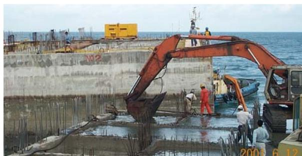
台中港外廓堤防工程沉箱填砂作業。
