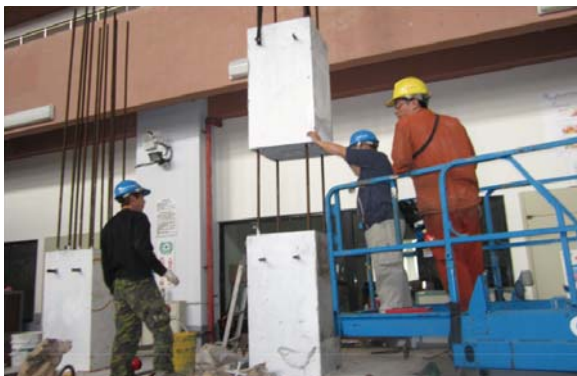
圖 7 NEWRCH3 節塊吊放製作
