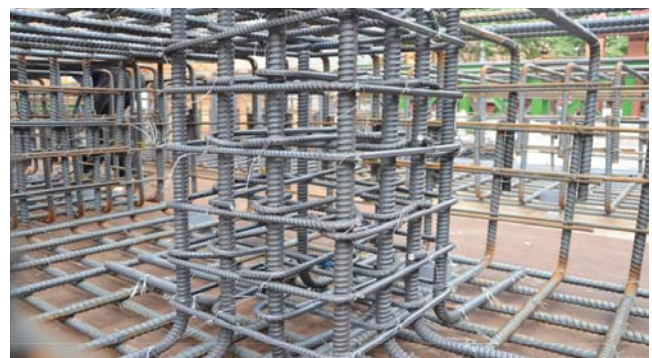
圖 3 NEWRC1,5 基礎鋼筋綁
