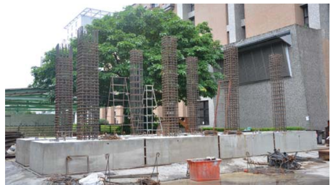
圖 2 BMRC1, NEWRC1,5 柱身鋼筋綁
