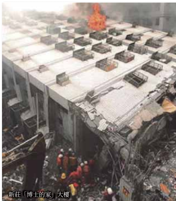
圖 5 1999 年集集地震之樓房崩塌
