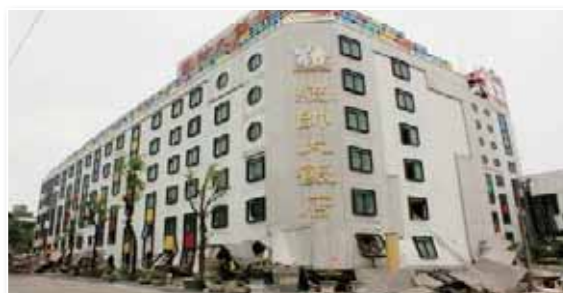
圖2 統帥飯店大樓倒塌現場
