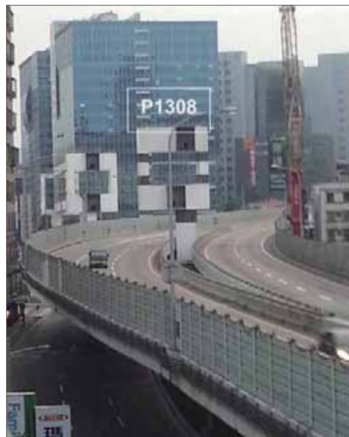
圖 30 64 線高架橋兩橋面間 3 m 空隙完成 P1308 橋墩現場照片
