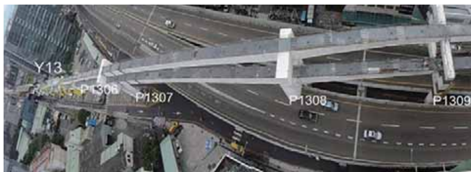
圖 34 上鋼箱梁及下鋼箱梁吊裝完成現場照片
