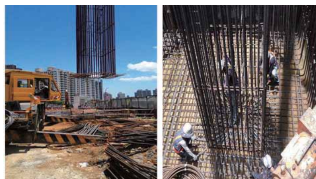
圖 27 墩柱鋼筋樣架施工
