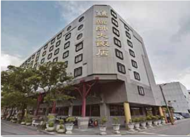
(A) 倒塌前 (取自 Google 地圖)
