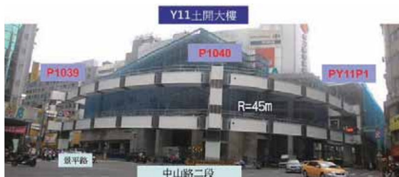
圖 9 疊式線形以半徑 45 公尺之曲線進入 Y11 車站
