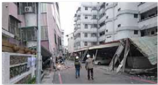
圖 4 白金雙星大樓倒塌現場
