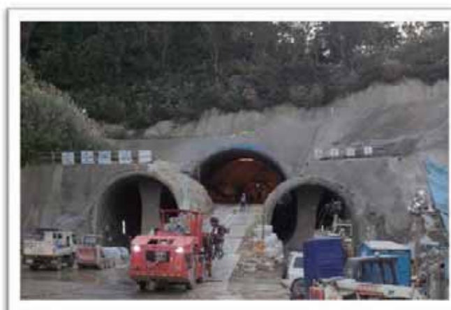
新店安坑一號道路二期工程 (玫瑰路至安泰路) 三孔近接隧道施工順利
