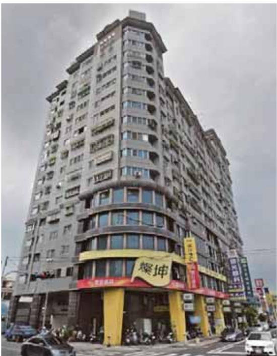
(A) 倒塌前 (取自 Google 地圖)
