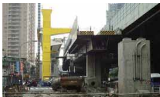
圖 23 拆除匝道引橋三跨大梁及橋面板現場照片
