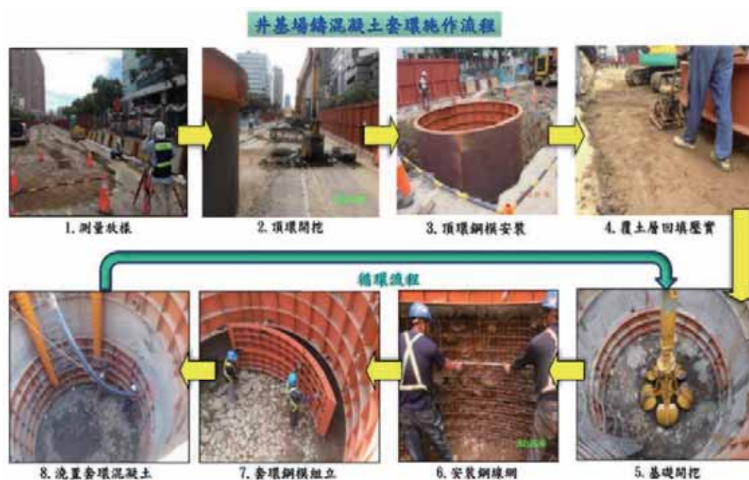
圖 14 井基施作流程
