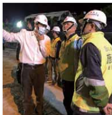
圖 8 花蓮震災勘災情形
