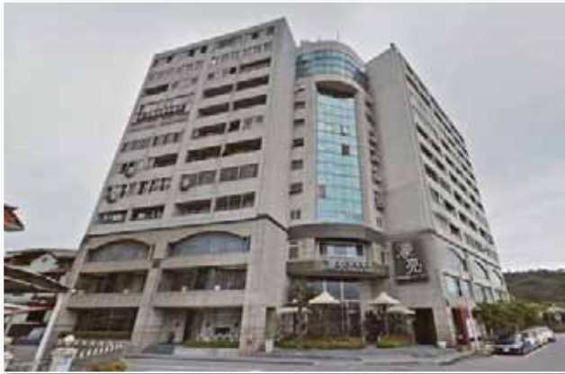
(A) 倒塌前 (取自 Google 地圖)
