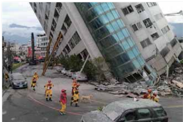
圖 6 雲門翠堤大樓緊急支撐作業
