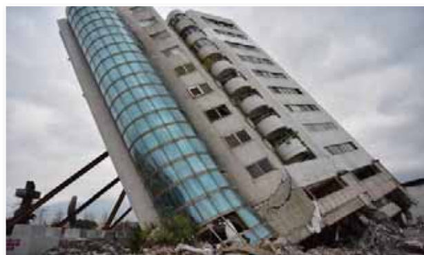
圖 3 2018 年花蓮地震之樓房崩塌
