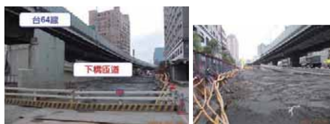
圖 22 拆除匝道引道現場照片
