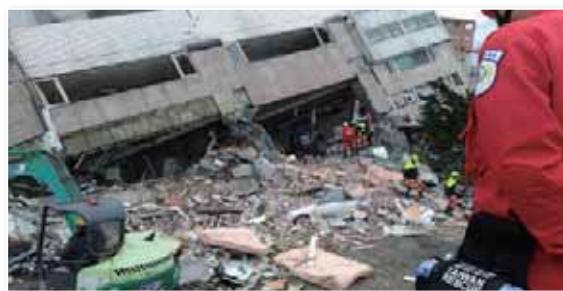
圖1 雲門翠堤大樓倒塌現場
