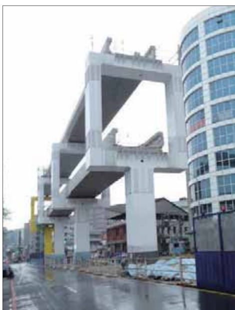
圖 11 簡支預鑄預力 U 型梁現場照片
