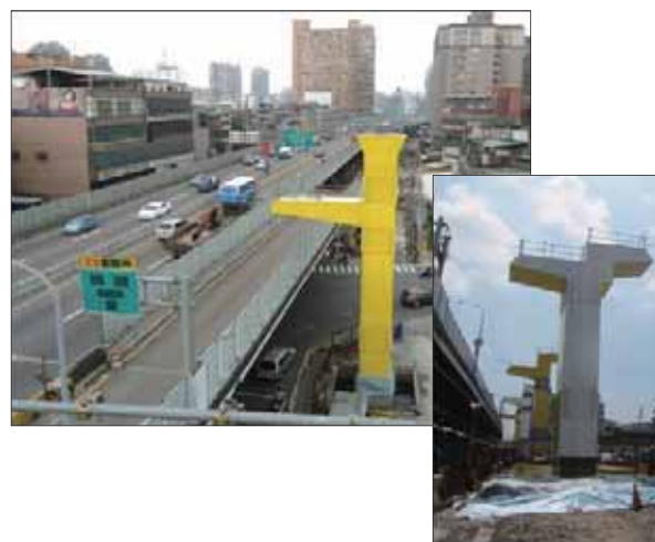
圖 18 Y13 ~ Y14 站間轉換區高架橋段現場照片
