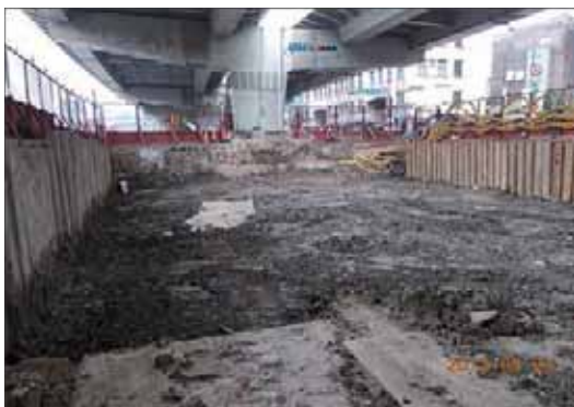
圖 28 降挖區現場照片
