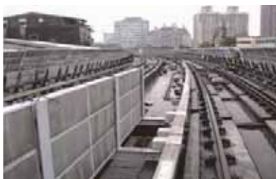
圖 27 高架段基座式軌道（北捷）
