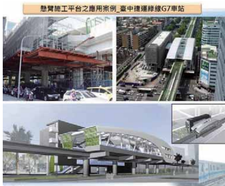
圖 16 懸臂施工平台 G7 站應用案例
