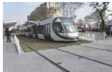
圖 29 埋入式軌道／花崗石鋪面
