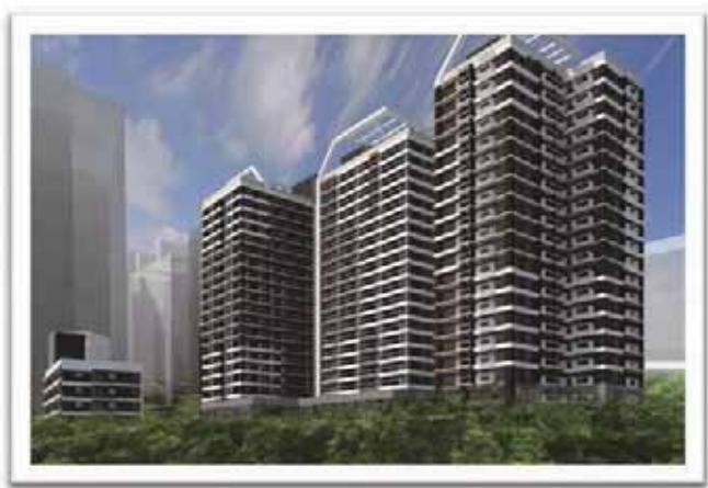
臺北市南港區東明公共住宅統包工程 丙基地順利竣工
