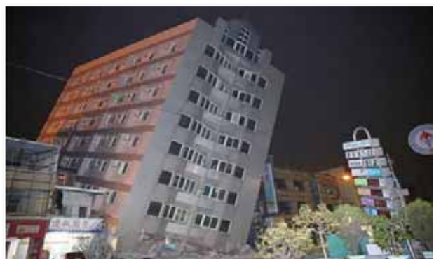
圖 2 2016 年美濃地震之樓房崩塌
