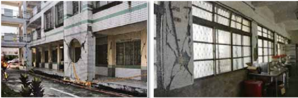
圖 7 建築物震害之主要樣態 (g) — 短柱效應之剪力破壞
