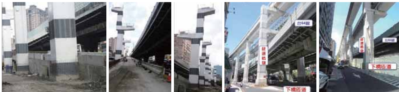
圖 24 台 64 線（中和一）下橋匝道復舊現場照片
