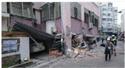
圖 3 吾居吾宿大樓倒塌現場
