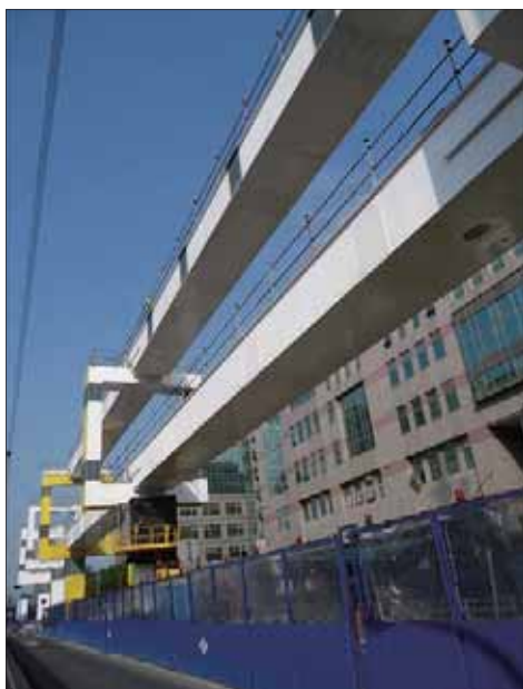
圖 12 連續鋼箱型梁現場照片
