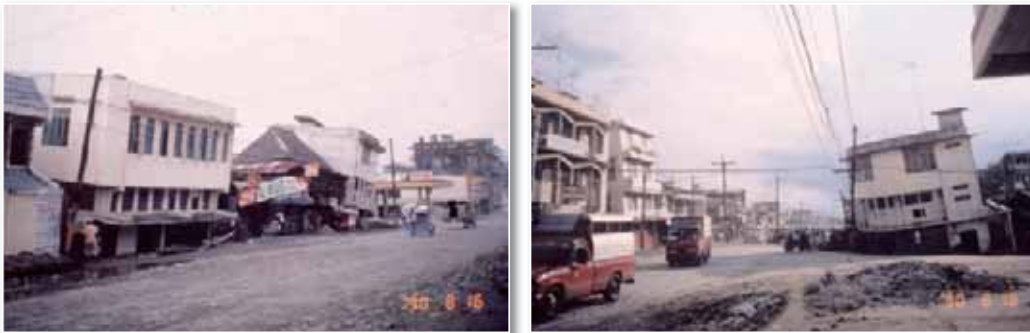
圖 8 建築物震害之主要樣態 (h) — 土壤液化導致建物傾斜沉陷
