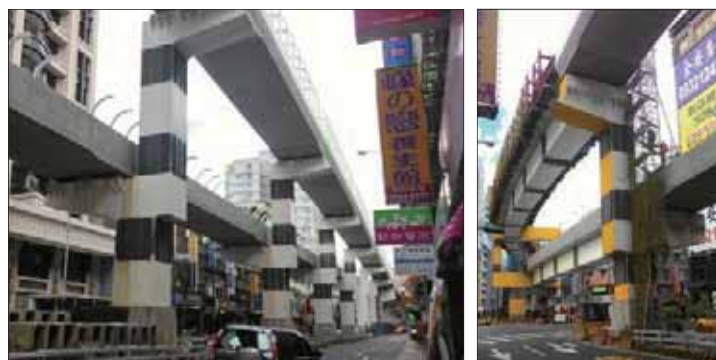
圖 16 Y10 ~ Y11 站間轉換區高架橋段現場照片
