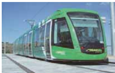
圖 28 埋入式軌道／混凝土鋪面
