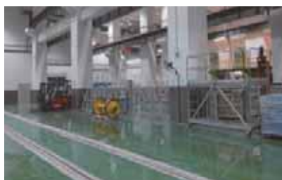
圖 31 廠房內埋入式軌道
