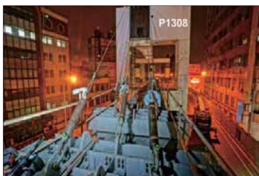
圖 32 P1308 橋墩框架鋼柱背拉鋼索吊裝現場照片
