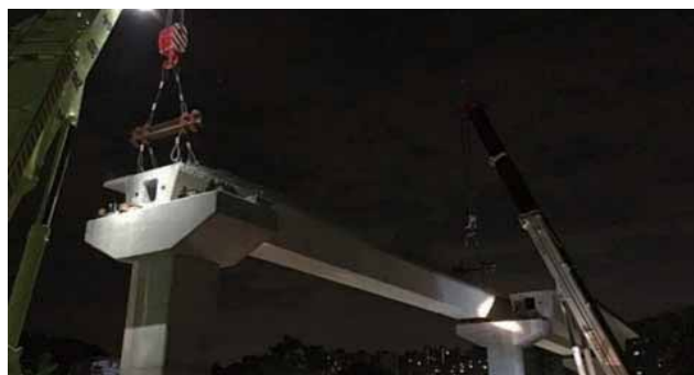
圖 28 高架橋預鑄吊裝施工
