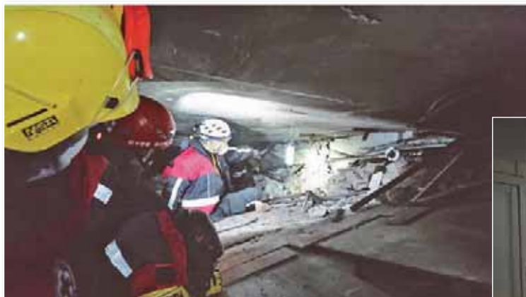
圖 4 倒塌災變現場一
