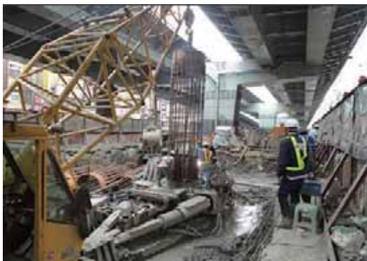
圖 29 鋼筋籠上下節鋼筋焊接現場照片
