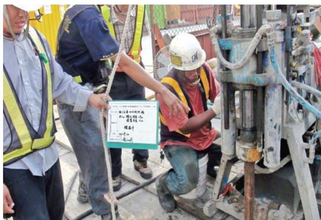
圖 8 海岸旁地鐵工程進行高壓噴射灌漿工法全景
