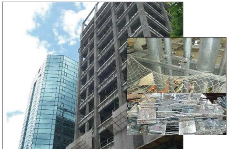
圖 9 大樓制震器固定座，經熱浸鍍鋅處理
