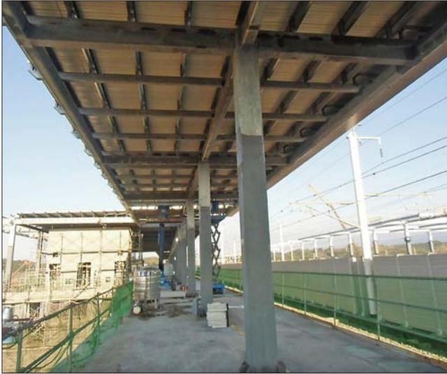
圖 11 高鐵苗栗站月台鋼架採用熱浸鍍鋅處理
