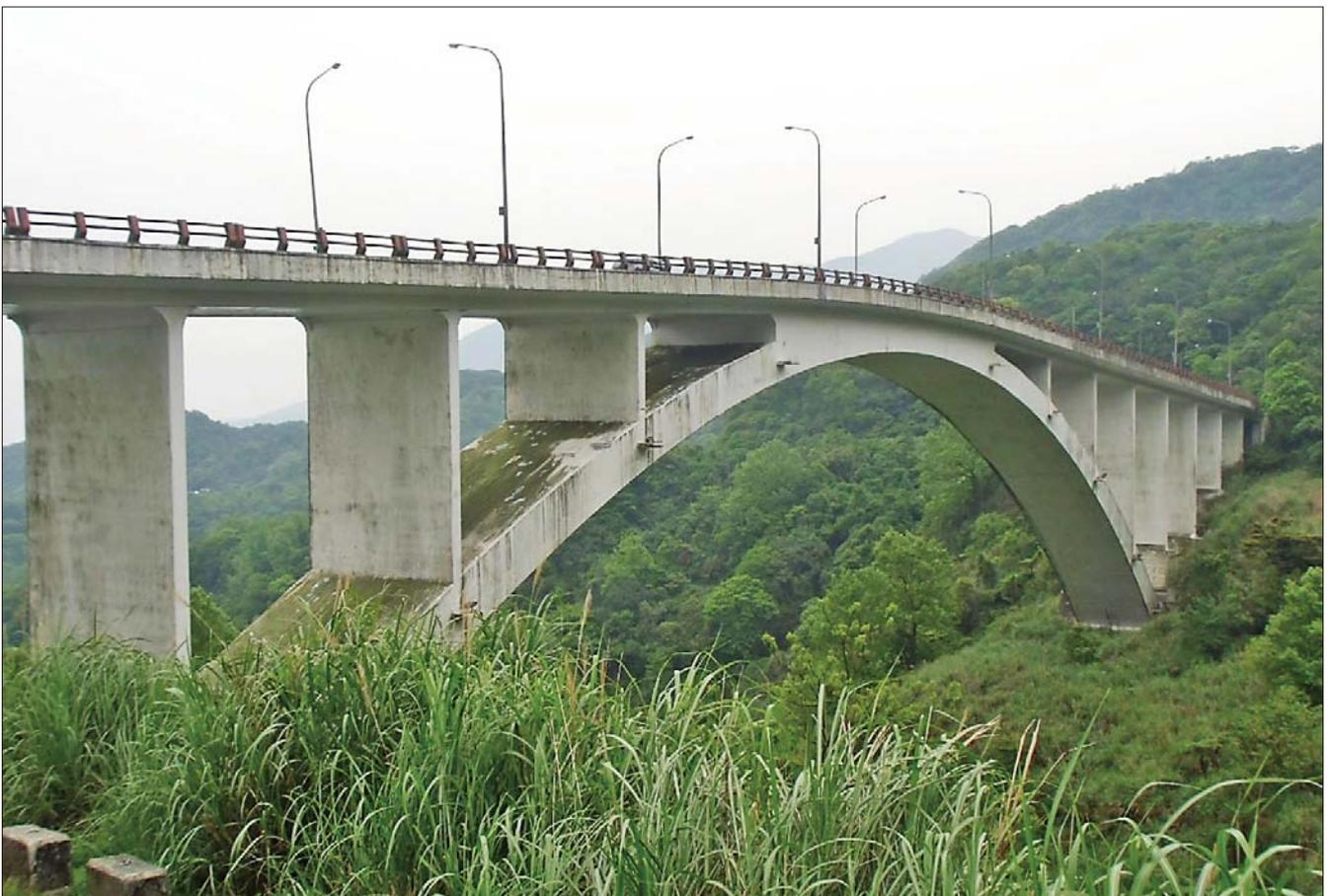
圖 12 台灣第一座熱浸鍍鋅橋梁－馬槽橋
