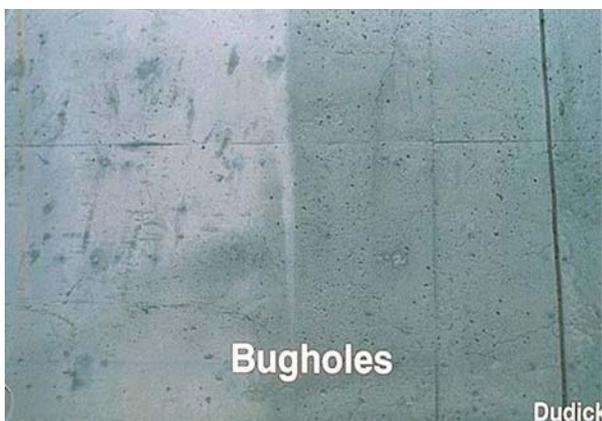
圖 4 混凝土缺陷—蟲洞
