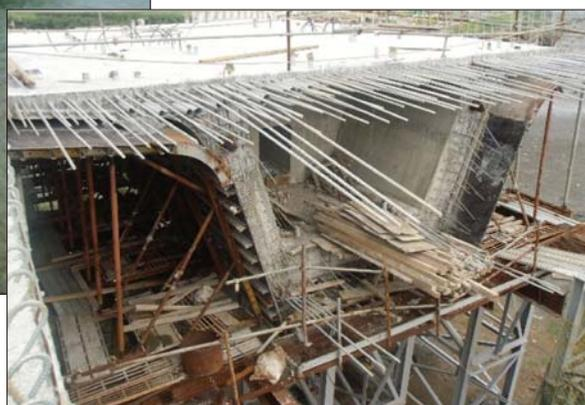
圖 19 鹿安橋，全橋鋼筋採用熱浸鍍鋅
