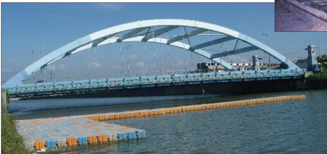
圖 14 第一座熱浸鍍鋅鋼拱橋—福興橋
