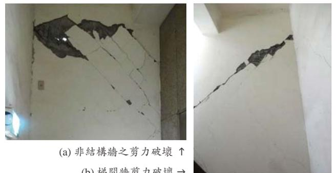
(a) 非結構牆之剪力破壞 ↑
