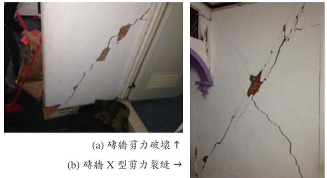
(a) 磚牆剪力破壞 ↑
