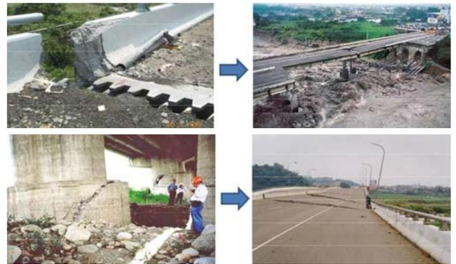
圖 2 台灣常見的橋梁崩塌破壞模式
