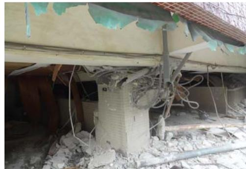
(b) 柱軸力破壞
