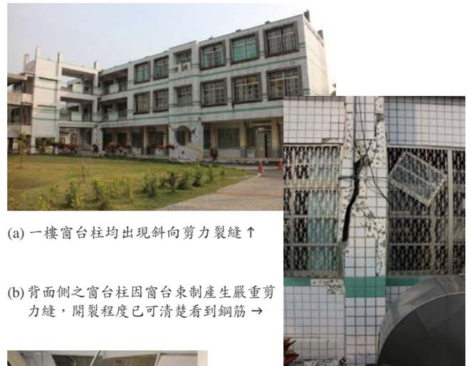
(a) 一樓窗台柱均出現斜向剪力裂縫↑
