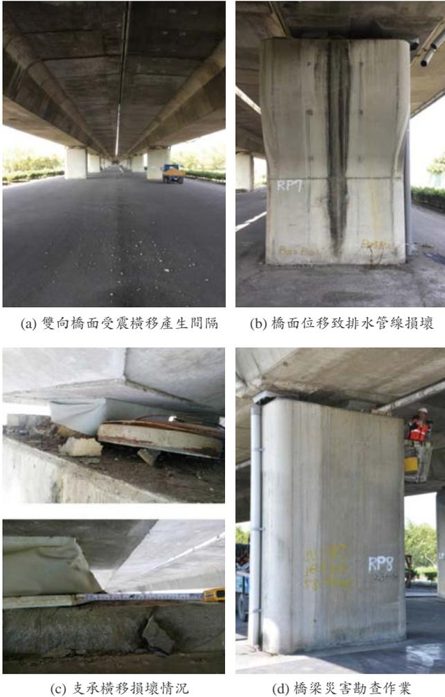
圖 19 台 86 線 24 號橋橋梁災害調查 (劉光晏及許家銓提供)
