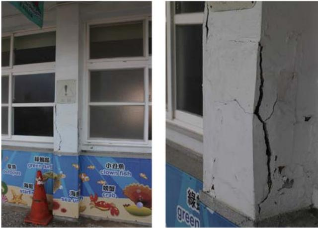
(a) 西棟柱體出現垂直向裂縫，疑似內部鋼筋鏽蝕膨脹，本次地震後出現開裂
