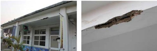
(b) 西棟走廊側梁底混凝土剝落，可見梁內鋼筋已生鏽（研判非本次地震造成）
