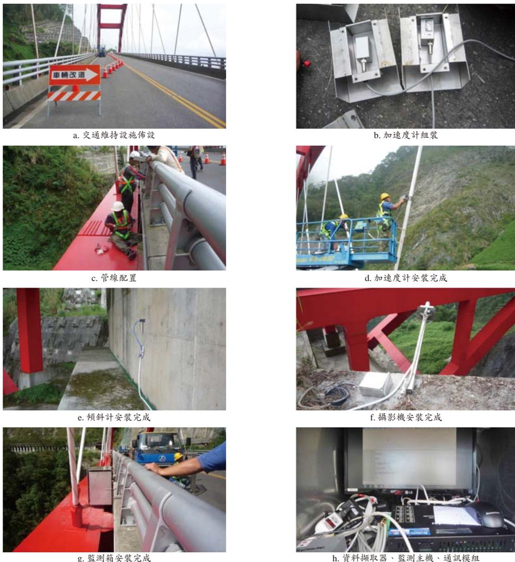
圖 12 監測系統安裝照片
