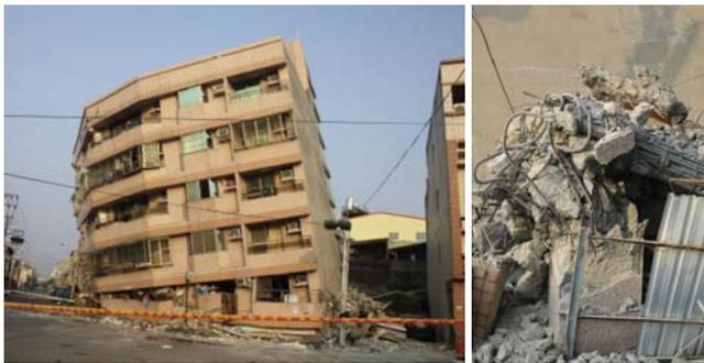
(a) 倒塌現況 (b) 柱軸力破壞
