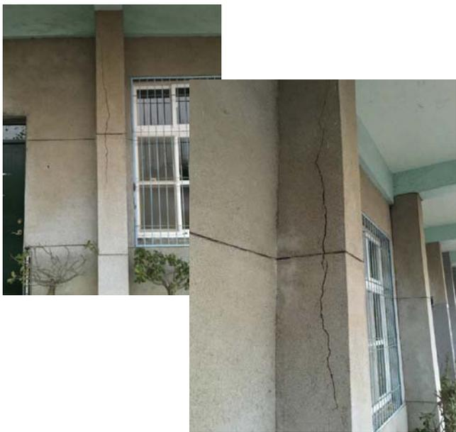
西棟柱體出現垂直裂縫，疑似內部鋼筋鏽蝕膨脹，地震作用後裂縫加大
