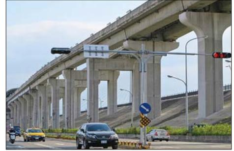
機場捷運與二重疏洪道堤防採雙柱堤防共構
