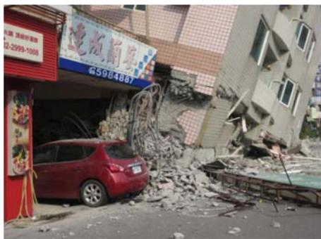
(b) 1 樓柱軸力破壞
