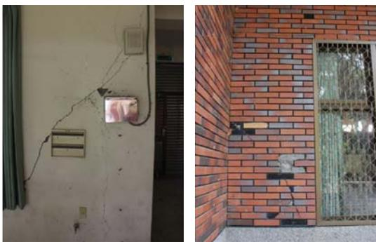
(c) 牆面出現斜向裂縫，另一面亦出現裂縫
