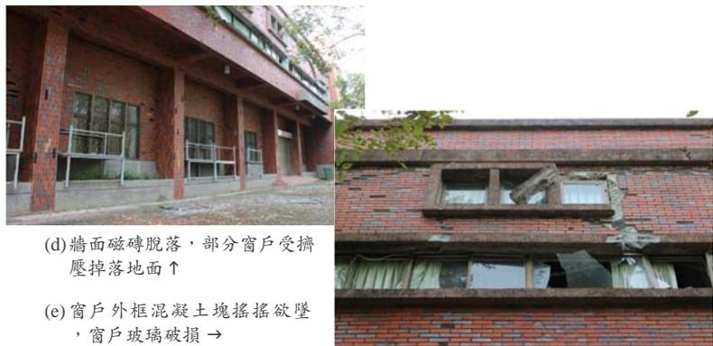
(d) 牆面磁磚脫落，部分窗戶受擠壓掉落地面↑
