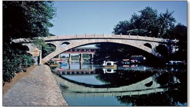
圖 6 趙州橋全景，橋長 50.82 m，橋寬 9 m，主拱高長比 0.38（洪如江攝）
