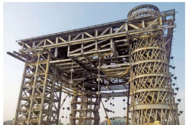
圖 23 鋼棒吊裝完成施工全景照片
