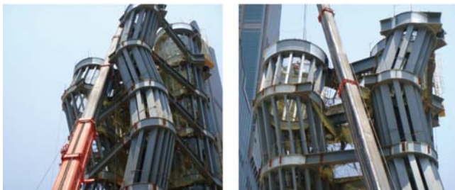
(7) 末節環標吊裝實際情況-1
