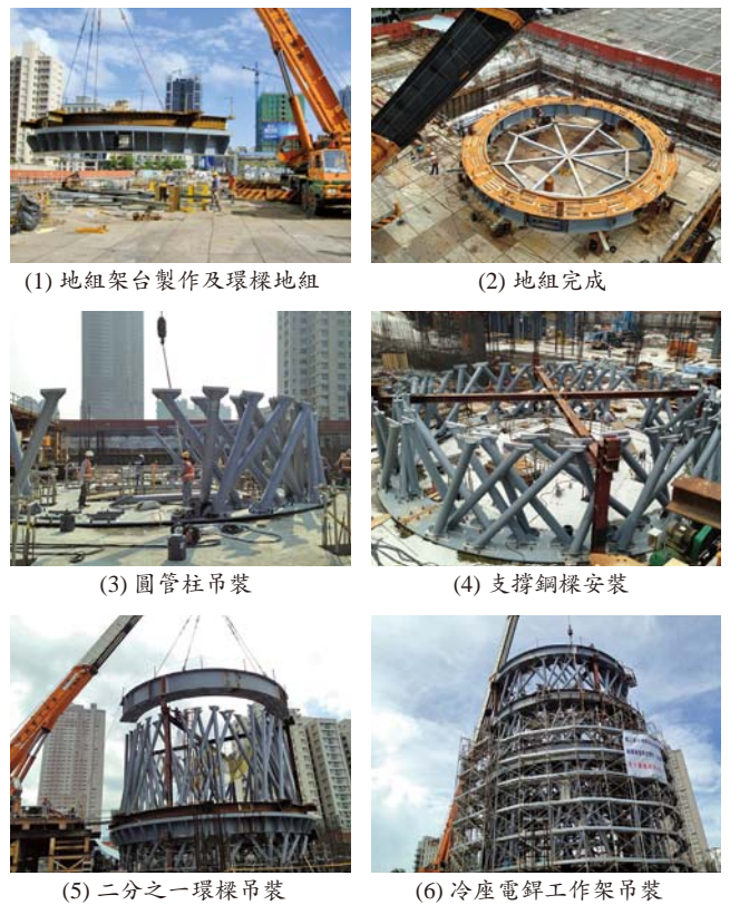
圖 18 Core B 施工實景照片 (春源鋼鐵提供)
