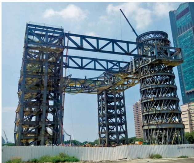
圖 20 屋頂桁架層吊裝施工照片 (春源鋼鐵提供)
