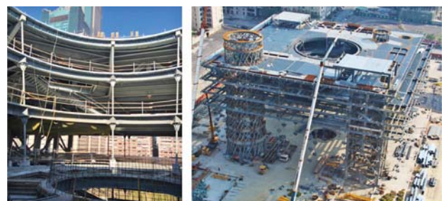
圖 24 鋼棒於天井區施工照片
