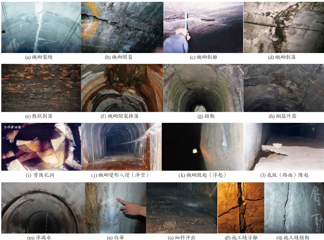
圖 5 數種常見的隧道襯砌異狀（修改自王泰典等 [17] ）
