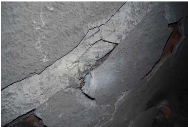
圖3 集集線鐵路建於1920年前後，隧道採用磚塊壘砌支撐，於1999年集集地震中受損後採鋼線網噴凝土補強，因勁度差異過大，不過幾年即可見噴凝土龜裂甚至剝落。隧道已於2010年再度維修補強。攝於2007年秋。
