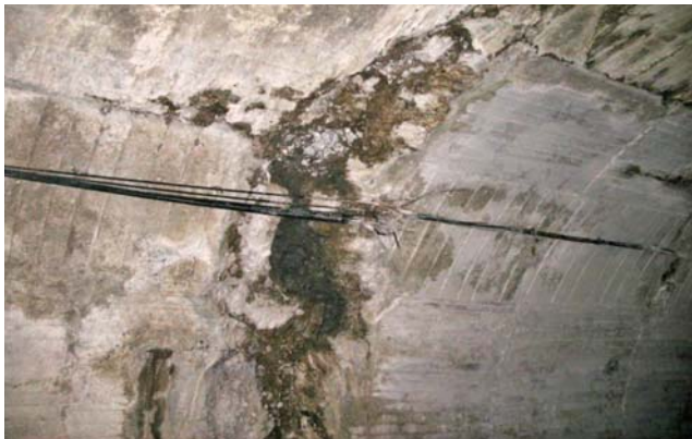
圖 2 獅球嶺隧道建於 1880 年代，因路線線型不佳，營運不及 7 年即廢棄。隧道採用磚塊及塊石疊砌支撐，因圍岩荷重持續作用造成過應力現象，磚塊及塊石中可以發現平行隧道周壁的裂縫，隧道壁面呈凹凸狀，地面有掉落的磚塊及塊石薄片。攝於 2008 年春。
