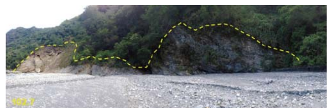
圖 19 河岸淘刷照片
