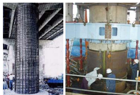
圖 4 傳統 RC 包覆及鋼板包覆補強示意圖
