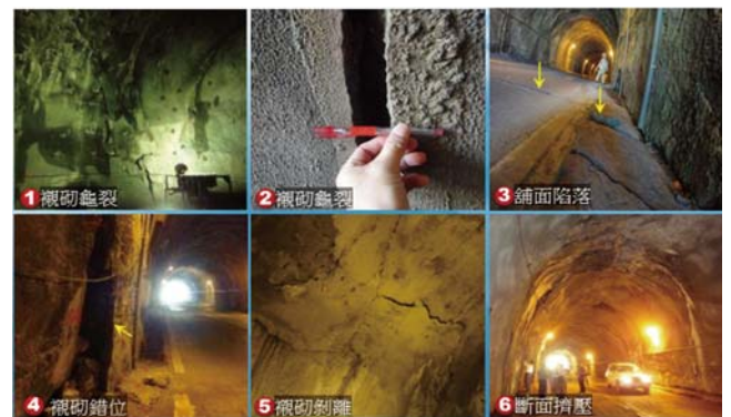
圖 2 嘉寶隧道襯砌損壞狀況
