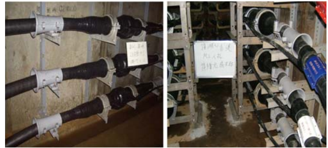
圖 11 鐵鋁配件塗船舶漆防銹蝕
