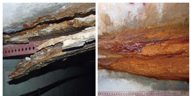
圖 9 隧道頂壁混凝土龜裂及鋼筋銹蝕
