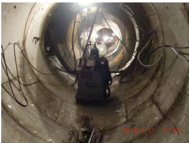
圖 8 鋼襯板補強施工
