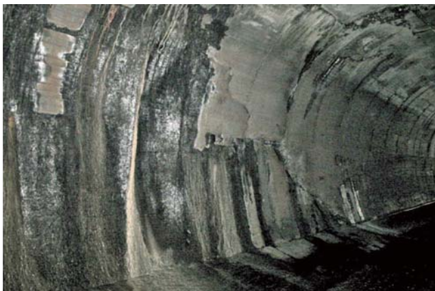
圖 1 烏山嶺隧道建於 1920 年代，建成後歷經 1950 年代末期、1970 年代初期以及 2000 年代中期 3 度修補，仍無法復原其設計功能及結構性能。上圖為 2004 年初檢測發現之襯砌環狀剝落，圍岩可見；下圖為斜向裂縫，襯砌錯移沿裂縫發展，有明顯的滲漏水及白華現象。嘉南農田水利會即將建造新烏山嶺隧道，確保烏山頭水庫水源。
