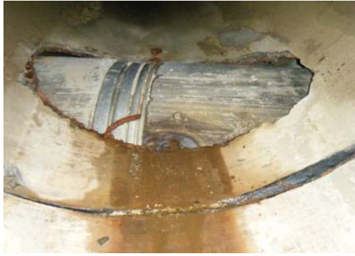
圖 9 管身遭污水管橫向穿破
