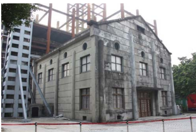
圖 21 煙囪及鍋爐房外觀 (2013 年 12 月份建物情況)
