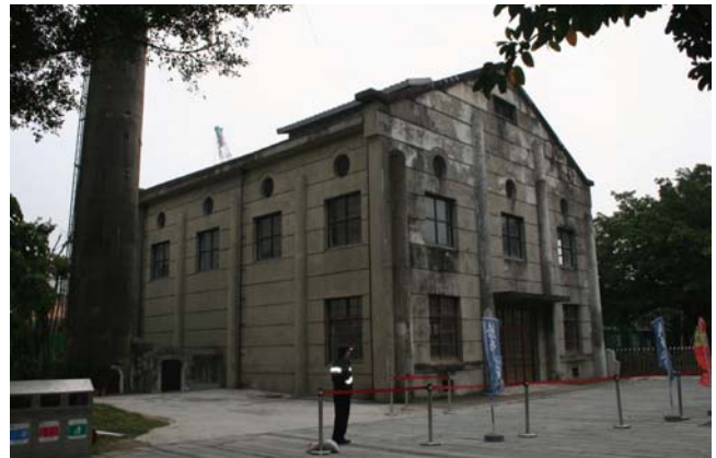
圖 18 煙囪及鍋爐房外觀（2012 年 4 月份建物情況）
