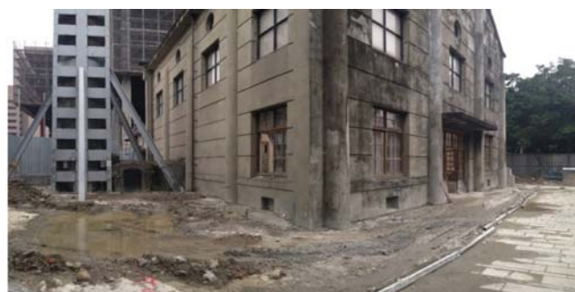
圖 23 煙囪及鍋爐房外觀 (圍牆內) (2014 年 06 月份建物情況)
