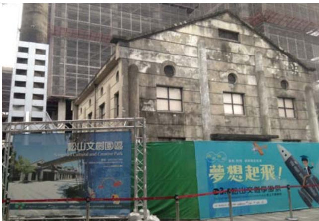
圖 22 煙囪及鍋爐房外觀 (圍牆外) (2014 年 06 月份建物情況)
