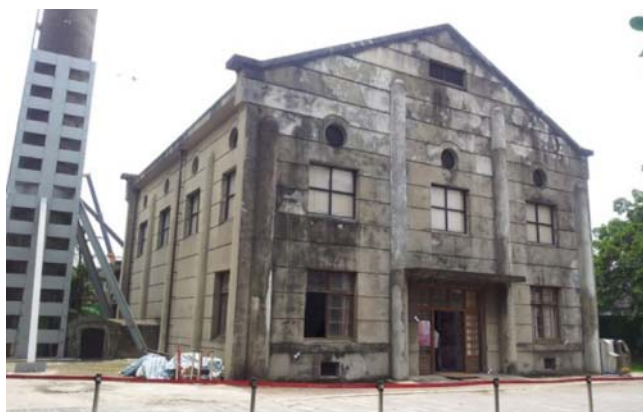
圖 20 煙囪及鍋爐房外觀 (2013 年 6 月份建物情況)
