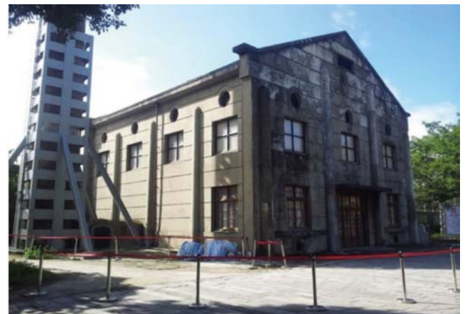
圖 19 煙囪及鍋爐房外觀（2012 年 12 月份建物情況）
