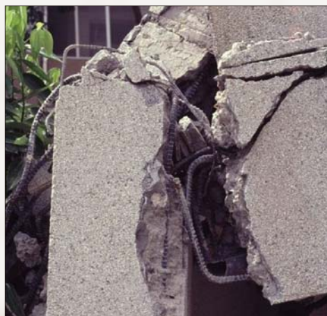
圖 17 梁筋錨定不足破壞
