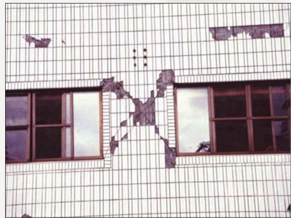
圖 8 短柱剪力破壞例
