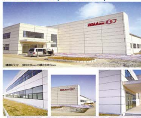
● 工廠外牆(大陸常州)
