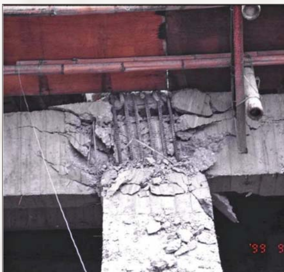
圖 6 接頭未配置箍筋之破壞例 (2)
