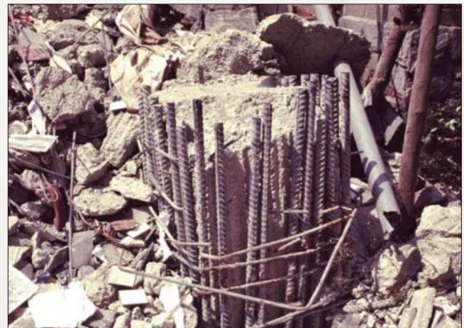
圖 4 柱筋搭接破壞案例
