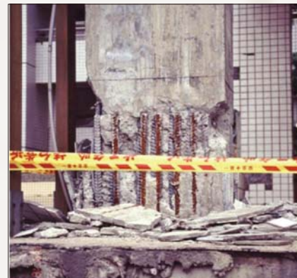
圖 3 柱筋搭接錯誤例
