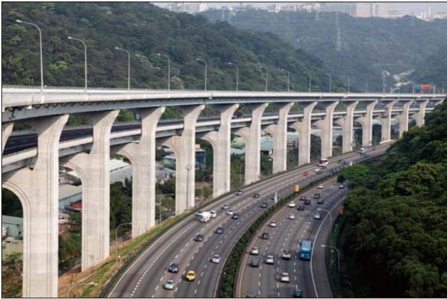
照片 1 五楊高架工程 (一)
