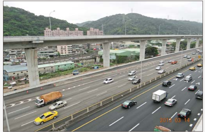
照片 2 五楊高架工程 (二)
