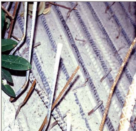
圖 16 繫筋 90°彎鉤拉開破壞
