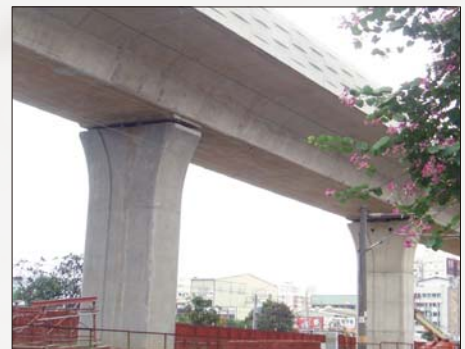
照片 8 台中鐵路高架工程
