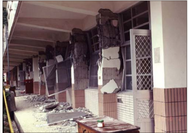
圖 7 短柱效應的破壞例
