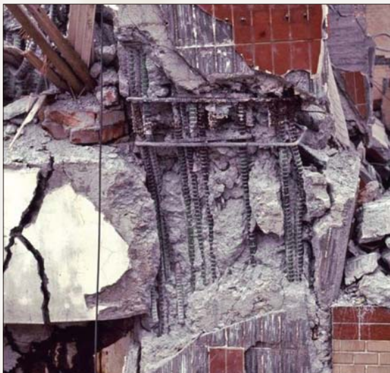
圖 5 接頭未配置箍筋之破壞例 (1)
