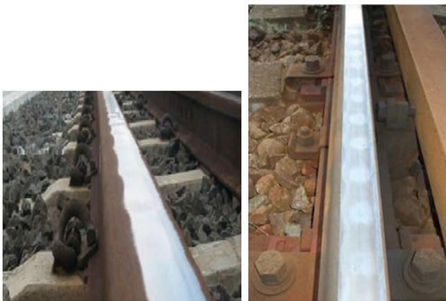
圖 4 鋼軌的波狀磨耗 [5,6]
