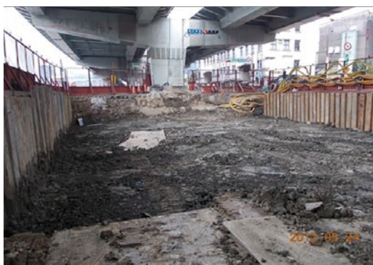
圖 28 降挖區現場照片
