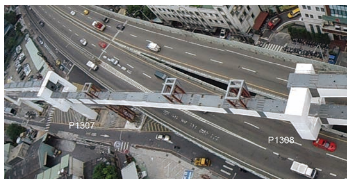
圖 33 上鋼箱梁之臨時支撐架佈置於下鋼箱梁現場照片
