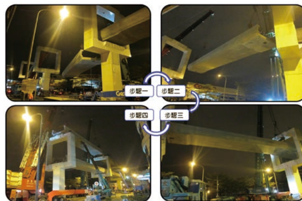
圖 14 U 型梁於框架鋼橋墩之吊裝現場照片
