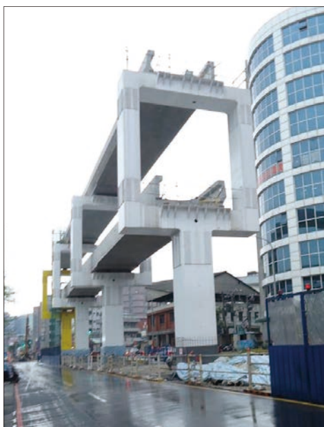
圖 11 簡支預鑄預力 U 型梁現場照片
