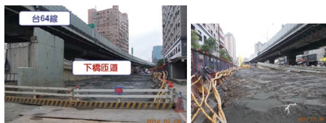
圖 22 拆除匝道引道現場照片
