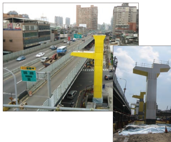
圖 18 Y13~Y14 站間轉換區高架橋段現場照片
