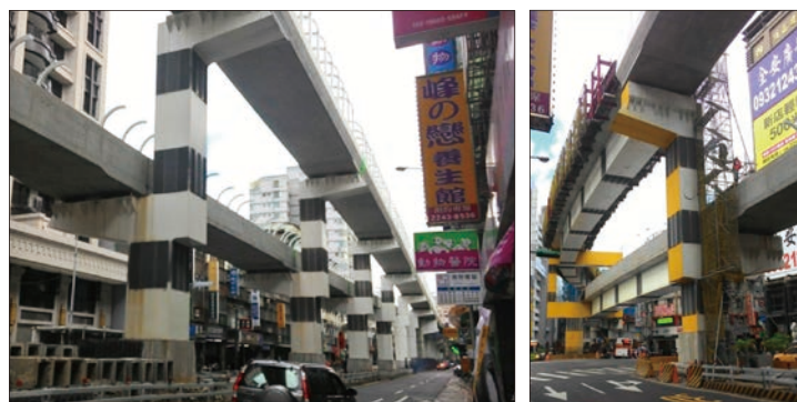
圖 16 Y10~Y11 站間轉換區高架橋段現場照片
