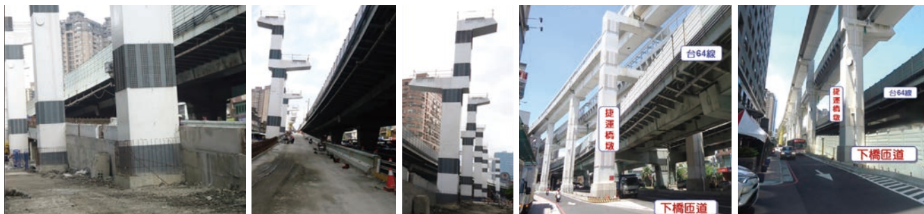
圖 24 台 64 線（中和一）下橋匝道復舊現場照片
