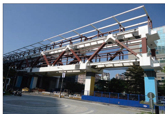
圖 7 疊式月台高架車站結構透視圖及照片
