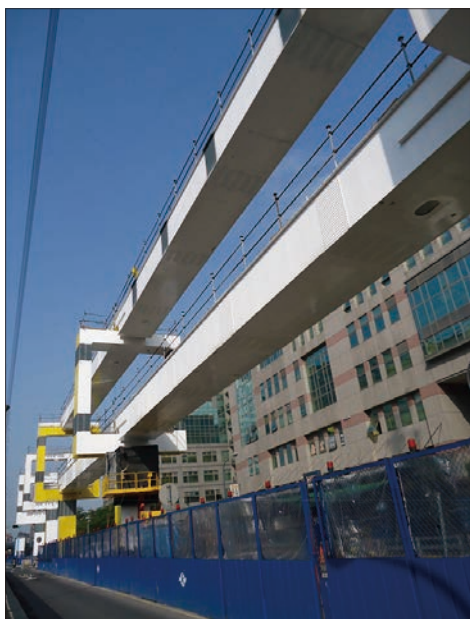
圖 12 連續鋼箱型梁現場照片
