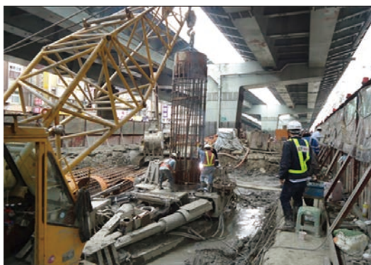
圖 29 鋼筋籠上下節鋼筋焊接現場照片
