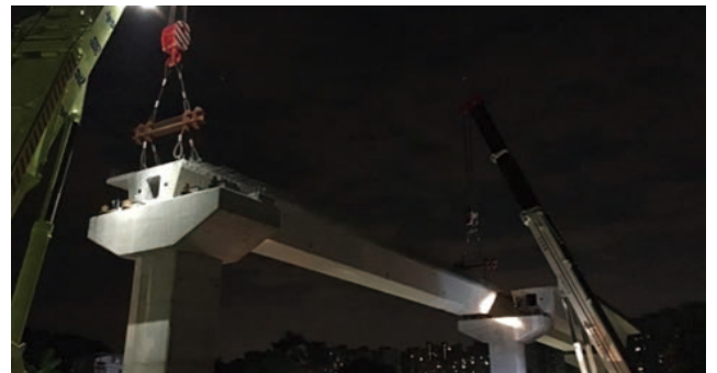
圖 28 高架橋預鑄吊裝施工
