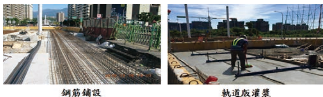
圖 30 平面段土建與軌道界面
