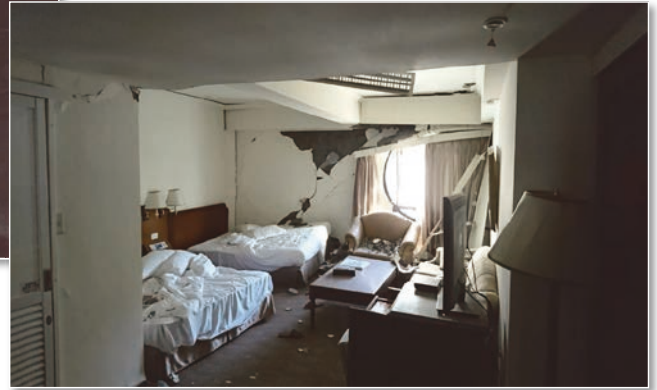
圖 5 倒塌災變現場二
