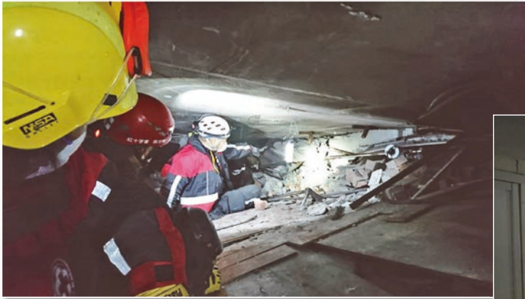
圖 4 倒塌災變現場一
