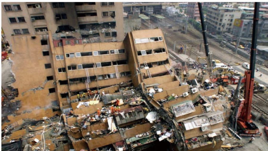
圖 1 1999 年集集地震之樓房崩塌（資料來源：路透社）
