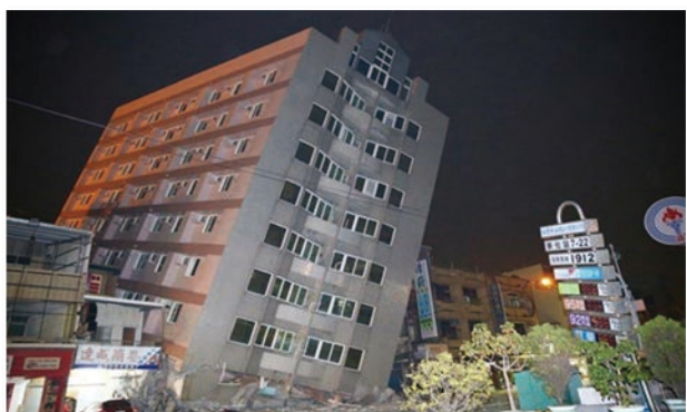
圖 2 2016 年美濃地震之樓房崩塌
