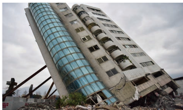
圖 3 2018 年花蓮地震之樓房崩塌
