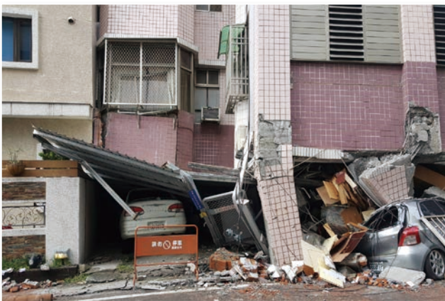
圖 4 弱層建築物一樓崩潰塌陷
