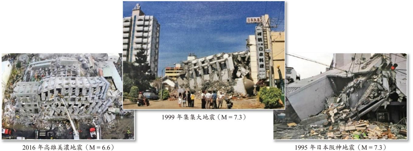
圖2 建築物震害之主要樣態 (b) — 整棟大樓崩塌橫倒地面
