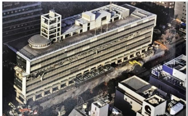
圖 6 建築物震害之主要樣態 (f) — 中間層崩塌
