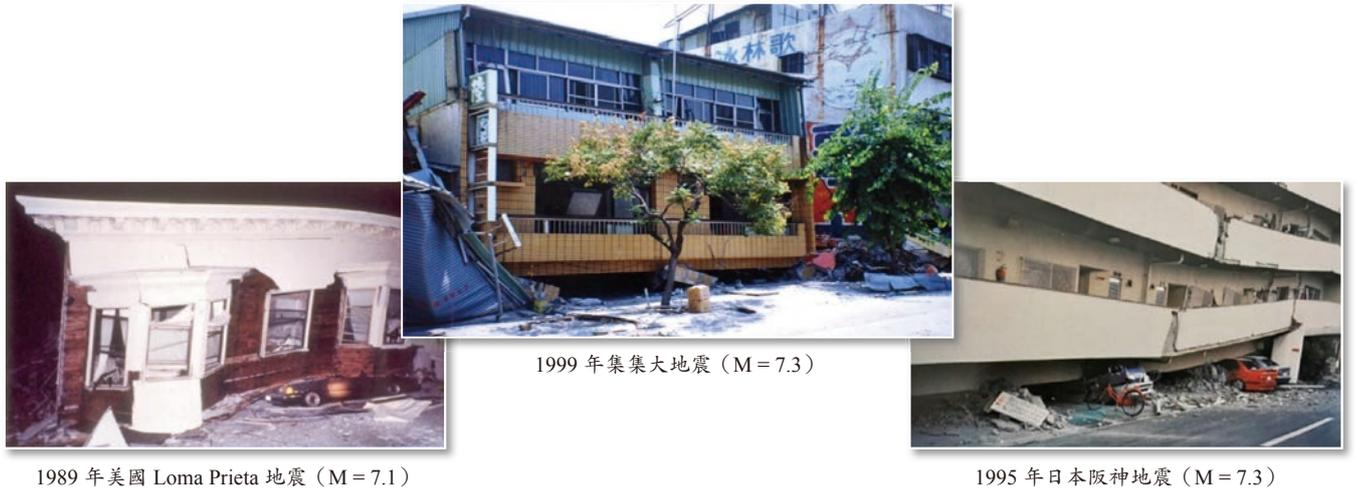
圖1 建築物震害之主要樣態 (a) — 底層柱壓垮崩塌
