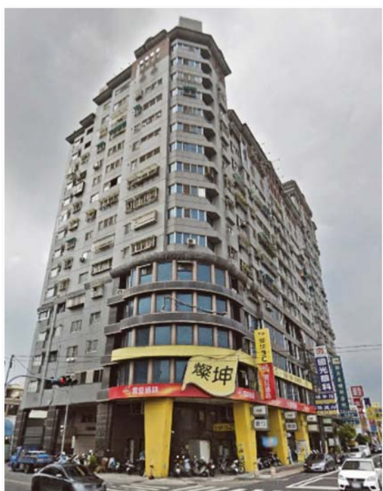
(A) 倒塌前 (取自 Google 地圖)
