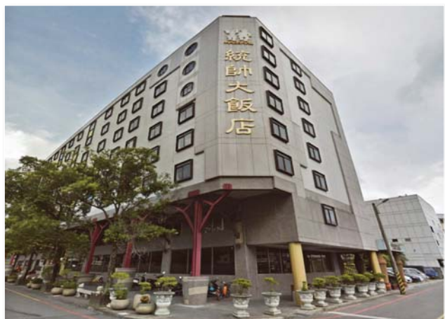
(A) 倒塌前 (取自 Google 地圖)
