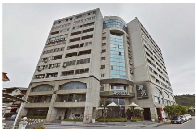
(A) 倒塌前 (取自 Google 地圖)
