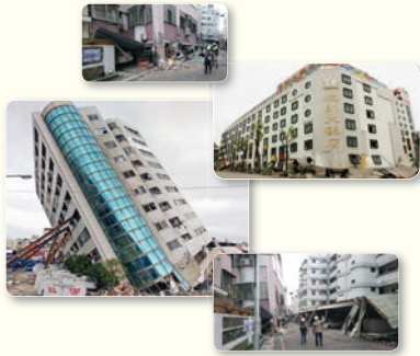
左上：0206 花蓮地震吾吾宿舍大樓倒塌現場 右上：0206 花蓮地震統帥飯店大樓倒塌現場 左下：0206 花蓮地震造成雲門翠堤大樓倒塌 右下：0206 花蓮地震白金雙星大樓倒塌現場
