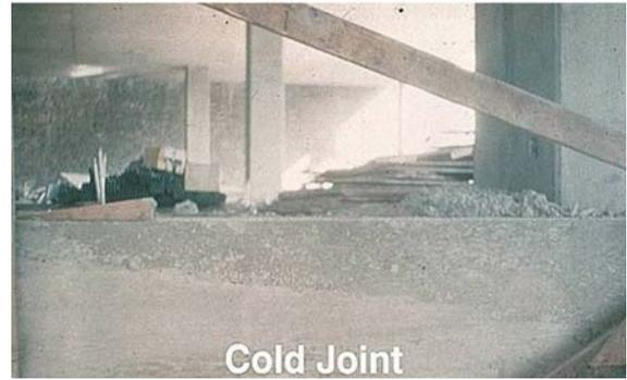
圖 8 混凝土缺陷—冷接縫龜裂
