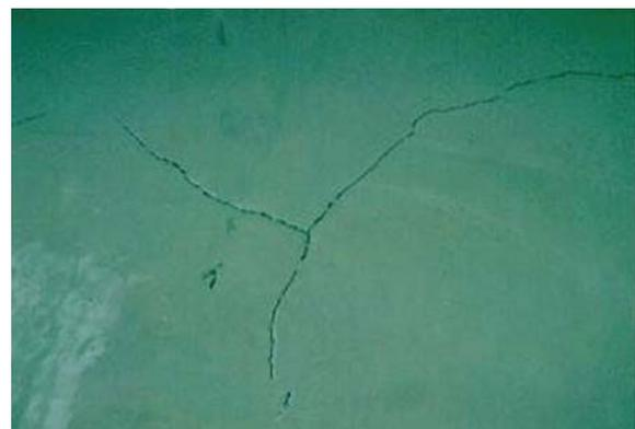
圖 6 混凝土塗裝缺陷—反射龜裂
