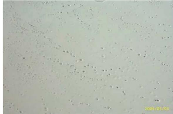
圖 5 混凝土塗裝缺陷—針孔
