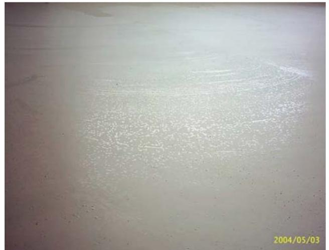
圖 11 混凝土塗裝缺陷—胺霧
