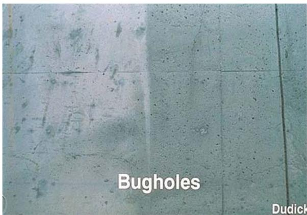
圖 4 混凝土缺陷—蟲洞
