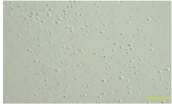
圖 10 混凝土塗裝缺陷—氣泡
