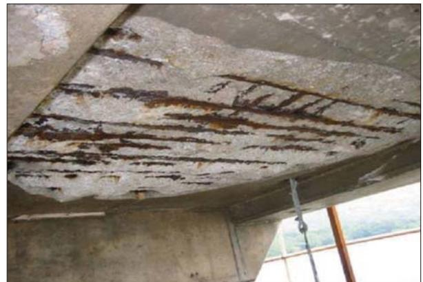
圖 1 鋼筋腐蝕而造成混凝土層剝落
