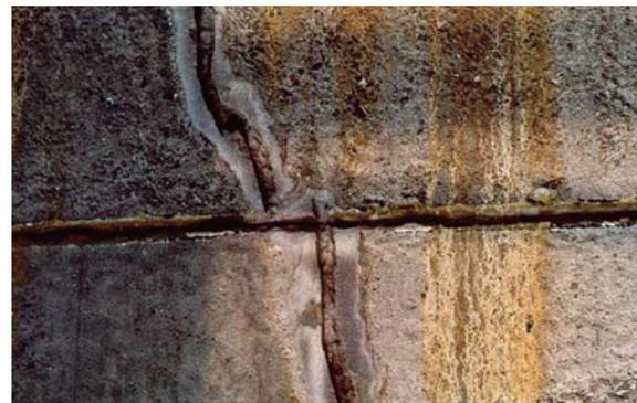
圖 9 混凝土缺陷—控制縫龜裂
