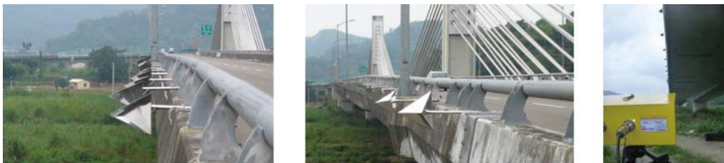
圖 6 微波雷達系統現地檢測作業照片
