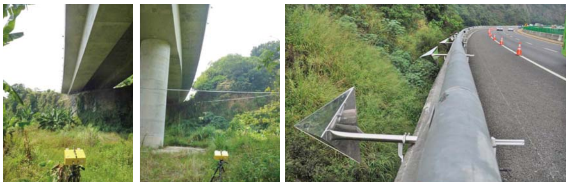
圖 12 東行橋跨儀器設置照片；測線 E-1 與測線 W-1
