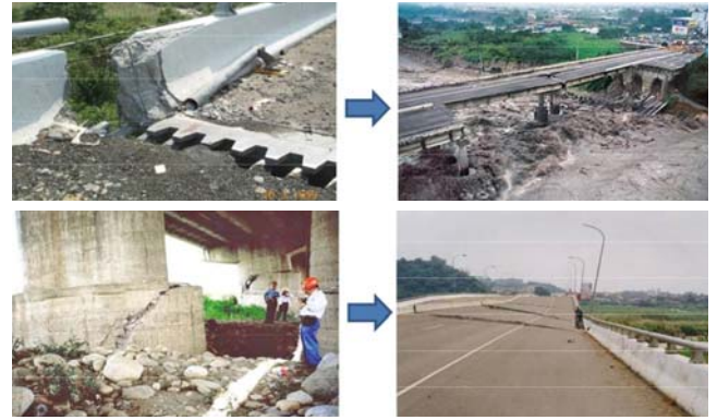
圖 2 台灣常見的橋梁崩塌破壞模式
