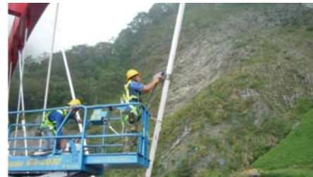
d. 加速度計安裝完成
