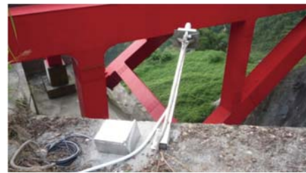
f. 攝影機安裝完成
