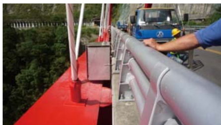
g. 監測箱安裝完成
