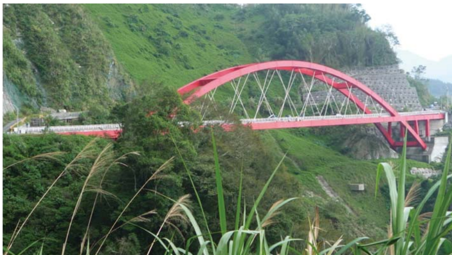
圖 1 台 18 線芙谷峩橋現況
