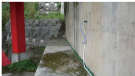
e. 傾斜計安裝完成
