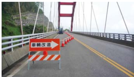
a. 交通維持設施佈設
