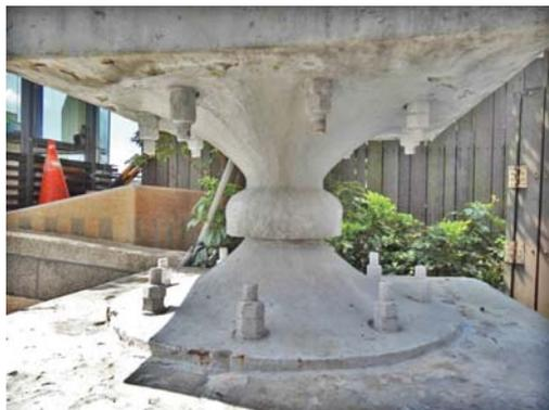
圖 3 橋塔底部鋼球軸承
