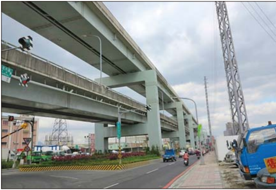
捷運與新北大道公路橋梁共構
