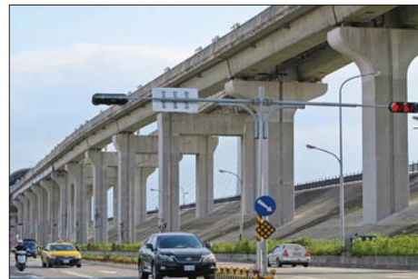
機場捷運與二重疏洪道堤防採雙柱堤防共構
