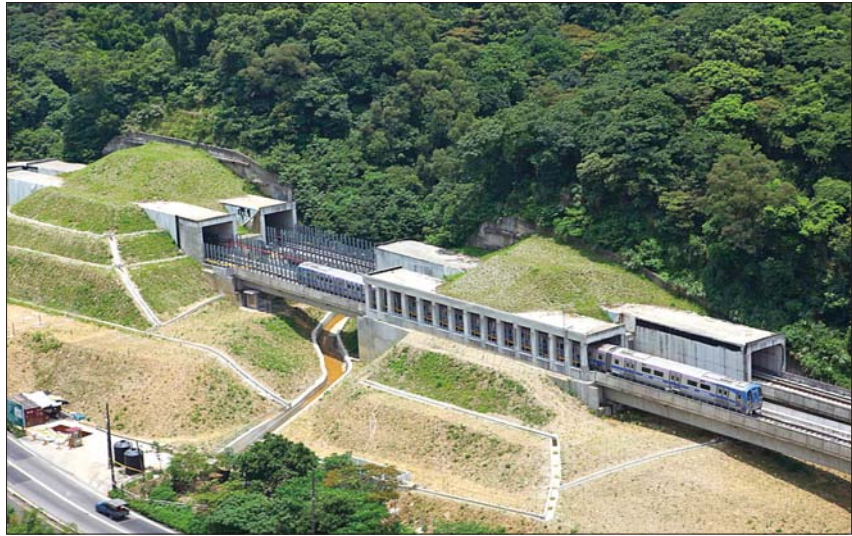
青山路段明挖隧道完工情形
