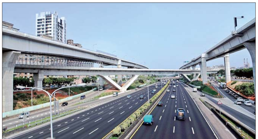
V型橋完成情形（上方為五楊高架道路）
