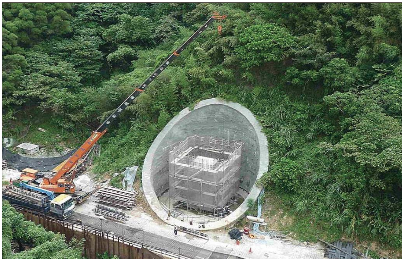
竹削型結構物施工照片
