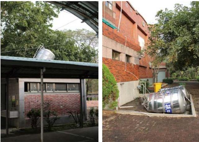
圖 15 台南市玉井國中多處水塔受損照片
