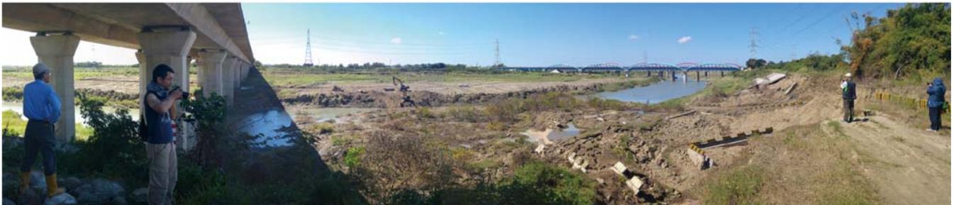
圖 24 南二高曾文溪橋堤岸側潰破壞情況 (許尚逸提供)
