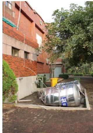
圖 15 台南市玉井國中多處水塔受損照片
