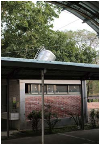
圖 15 台南市玉井國中多處水塔受損照片
