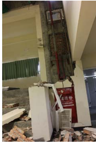
(a) 管道間因地震造成大量紅磚掉落
