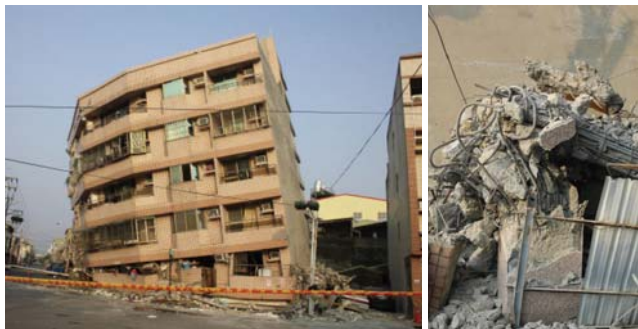
(a) 倒塌現況 (b) 柱軸力破壞
