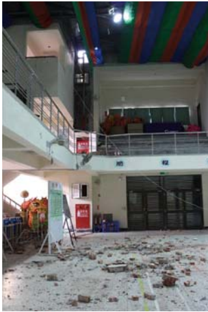
(a) 管道間因地震造成大量紅磚掉落
