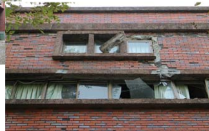
(d) 牆面磁磚脫落，部分窗戶受擠壓掉落地面 ↑
