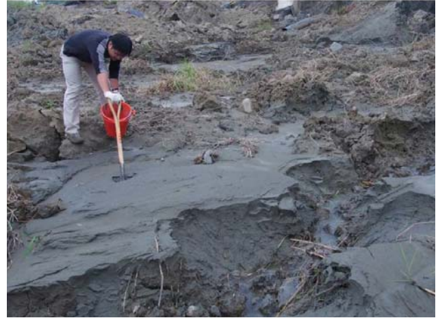
圖 25 2 月 15 日於曾文溪堤岸側潰處進行液化土砂取樣 (楊炫智提供)
