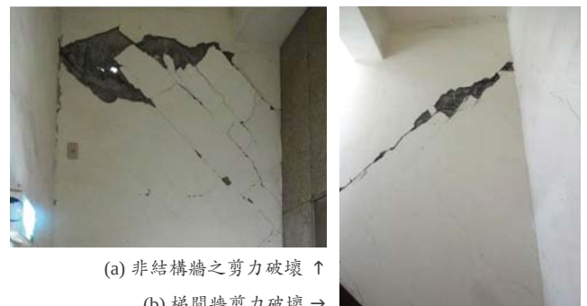
圖 11 錦繡世界大樓震損照片
