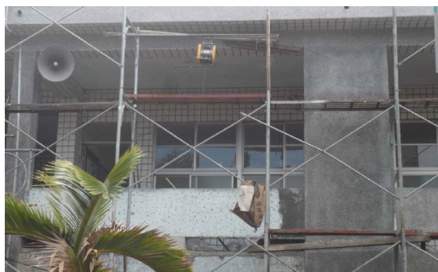
南一棟已完成翼牆及擴柱結構體施作，並未於地震中受損
