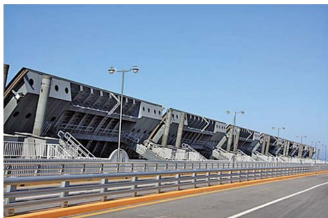
圖 12 行駛於新萬金堤防上，沿途經過的閘門
