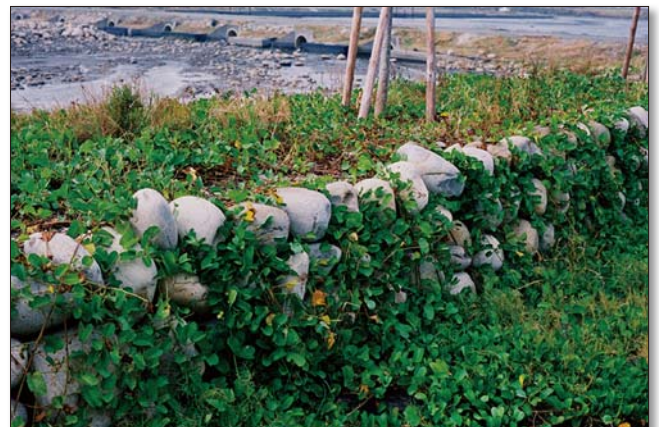
圖 22 彰化海邊的磊石矮牆，以藤類植物網捆綁之，越久越強（洪如江攝）
