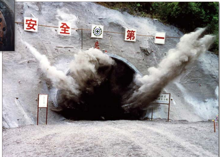
圖 5 爆炸開挖 （資料來源：台灣區國道新建工程局）
