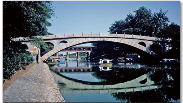
圖 6 趙州橋全景，橋長 50.82 m，橋寬 9 m，主拱高長比 0.38（洪如江攝）
