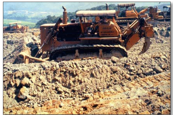
圖 3 推土機整地作業 （洪如江攝）
