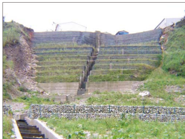
圖 26 台中案例一施工後（2009/08）（盟鑫公司提供）
