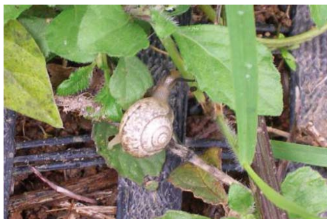
圖 30 暨大邊坡加勁擋土牆完工後生態豐富，加勁格網提供了動植物攀爬之平台 (周南山攝)
