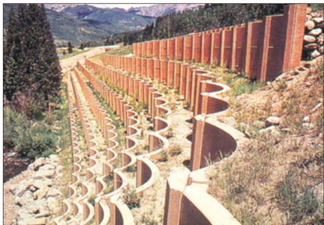
圖 10 I-70 造型優美的拱形面板式加勁擋土牆 （取材自科羅拉多州公路局）
