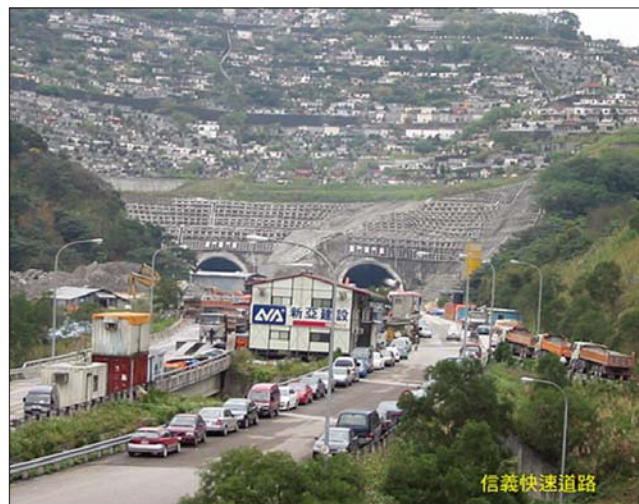
圖 3 台北市信義快速道路隧道洞口充斥了混凝土格梁結構（周南山攝）
