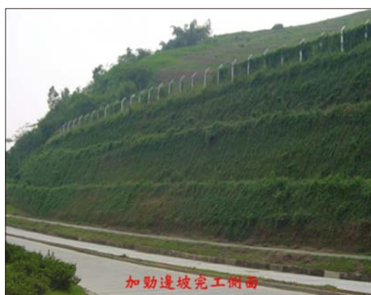
圖 17 暨南大學邊坡於九二一地震後重建，採用回包式加勁擋土牆（周南山攝）
