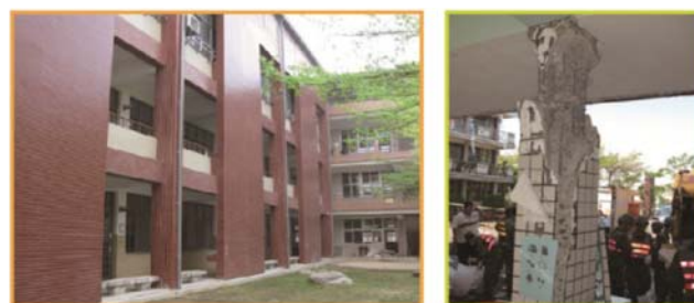
玉井工商(已補強) 無結構性損壞 玉井國中(未補強) 多處柱產生結構性損壞
