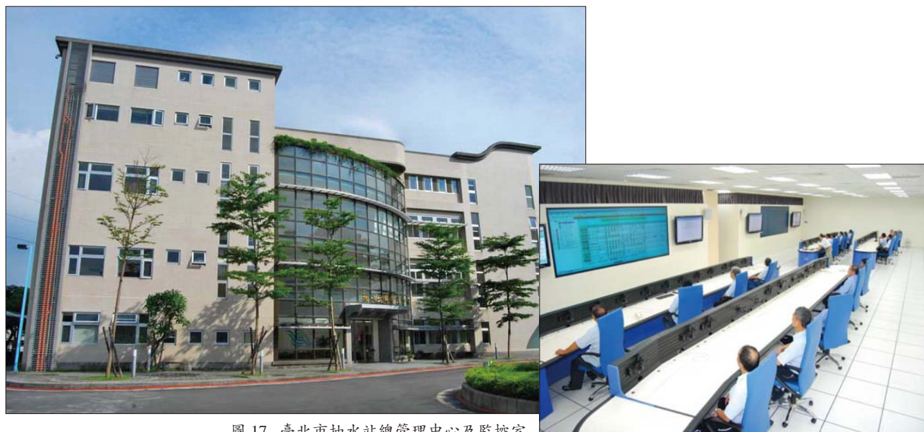
圖 17 臺北市抽水站總管理中心及監控室
