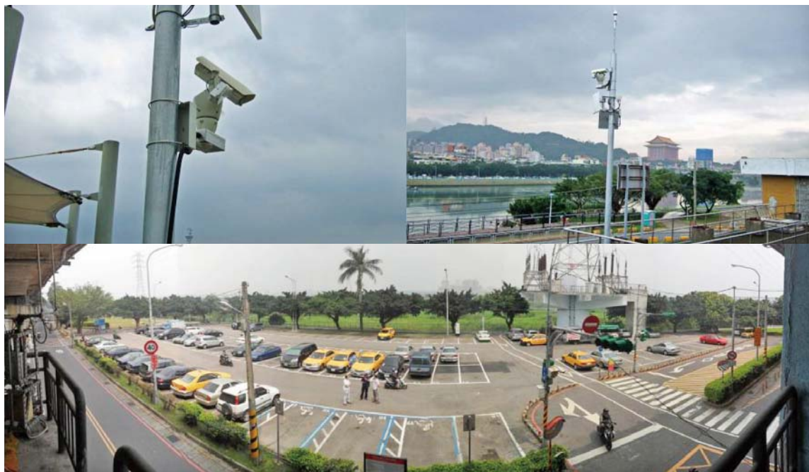
圖 4 CCTV 河川水情影像監視設備建置
