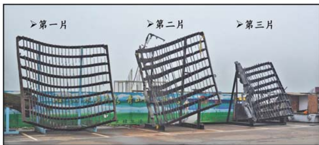
照片 1 石門水庫 PRO 進水口攔污柵受損情形
