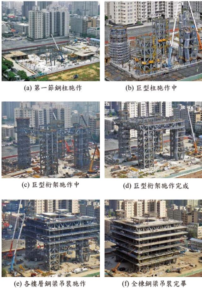
圖 25 施工流程說明照片
