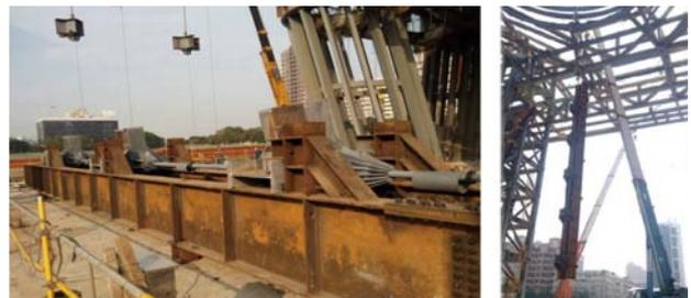
圖 22 鋼棒地組及吊裝施工照片 (春源鋼鐵提供)
