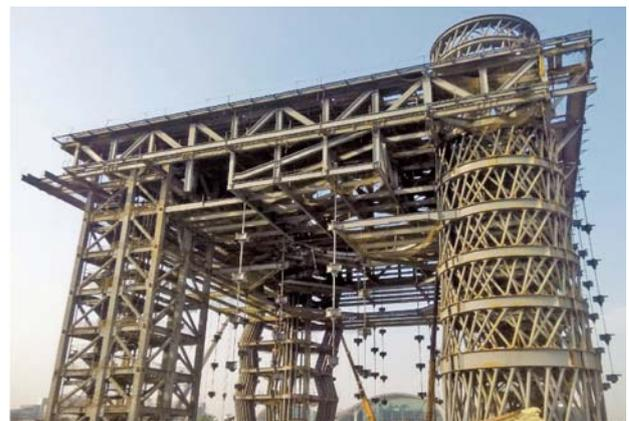
圖 23 鋼棒吊裝完成施工全景照片
