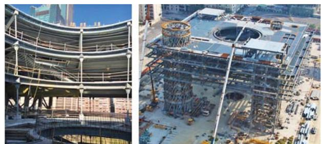
圖 24 鋼棒於天井區施工照片
