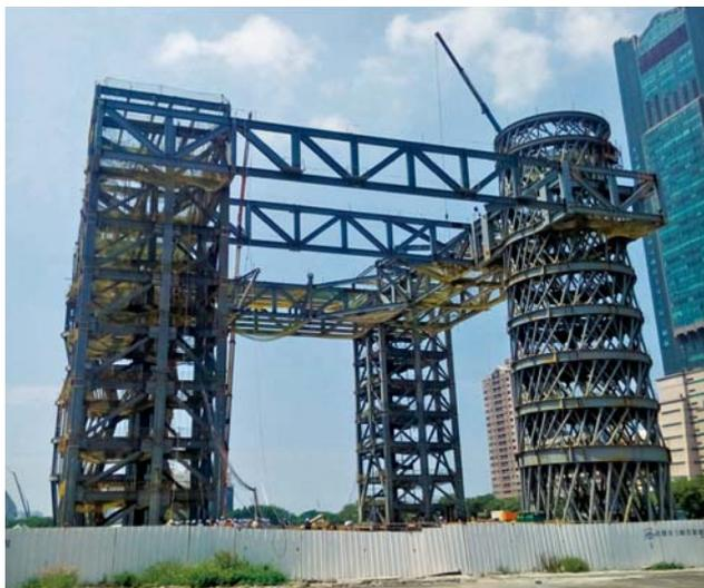
圖 20 屋頂桁架層吊裝施工照片 (春源鋼鐵提供)
