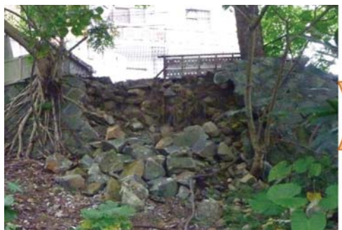
圖 12 臺北市大地處協助緊急改善涉及公共安全疑慮之人工邊坡案例
