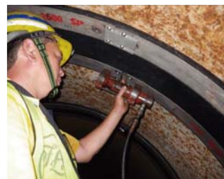
圖 5 內套環不銹鋼固定框施預力
