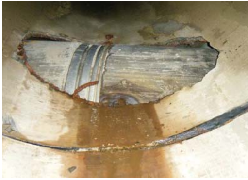
圖 9 管身遭污水管橫向穿破
